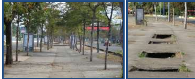
Foto 22: Avenida Naciones Unidas, cauce revestido, utilizado como andén peatonal. Fuente: Irañeta, Mayorga y Gutiérrez, 2008
