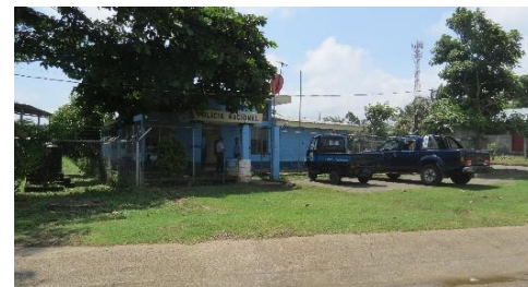
Ilustración 14 Estación de policía de casco urbano Cárdenas
