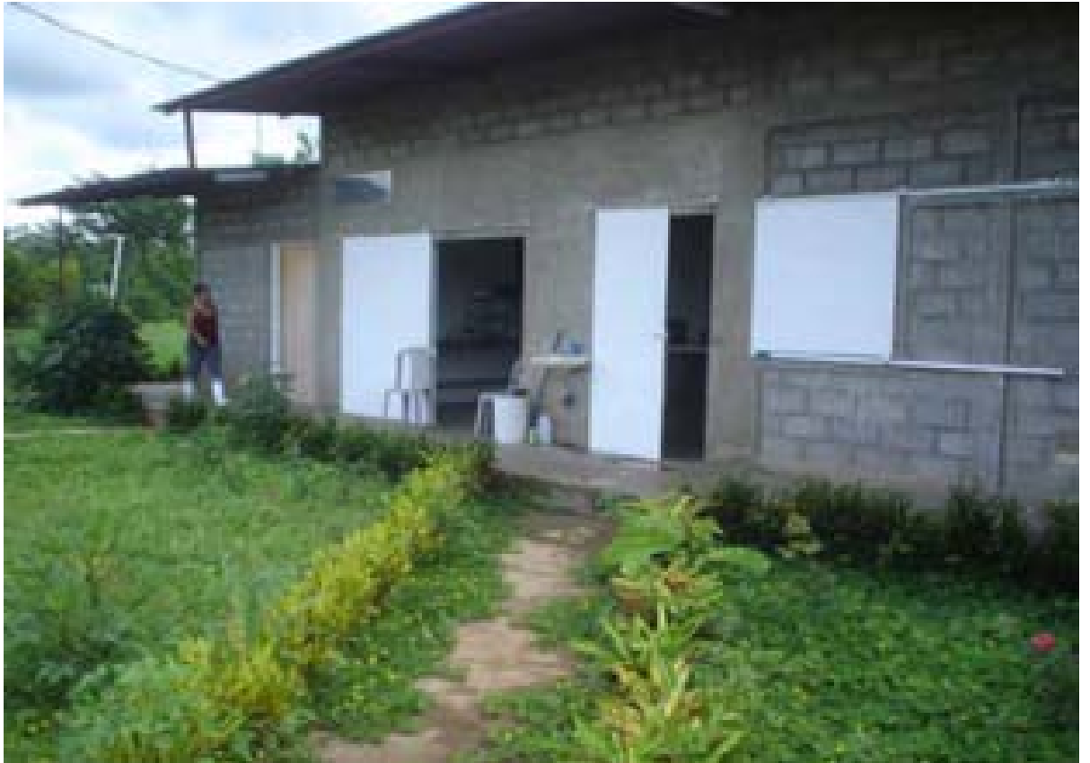
Figura No. 9 Puertas externas metálicas.
