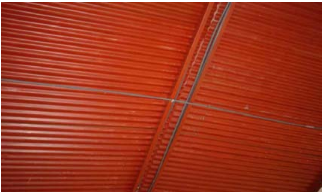
Figura No. 4. Techo con pintura anticorrosiva.
