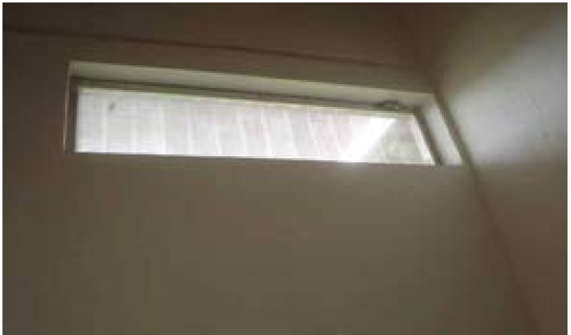
Figura No. 6. Ventanas protegidas con malla milimétrica.
