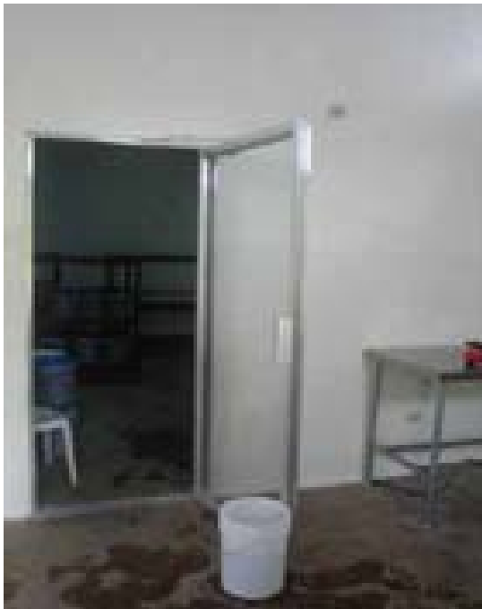
Figura No. 8. Puertas internas de vidrio.
