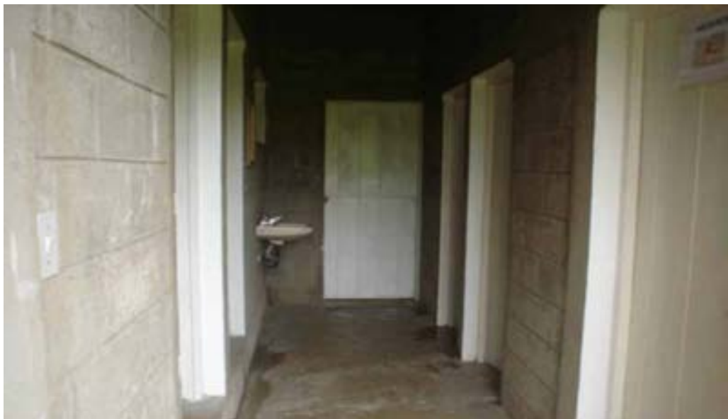
Figura No. 13. Area de Vestidores y Servicios Sanitarios.
