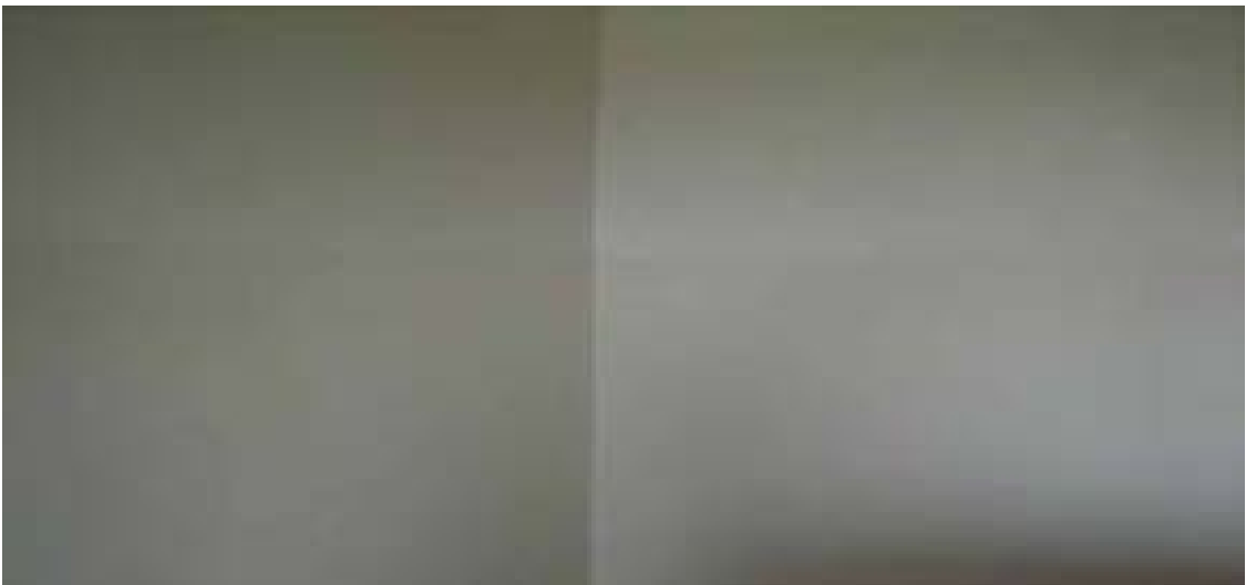
Figura No. 3. Paredes revestidas de pintura epóxica blanca.
