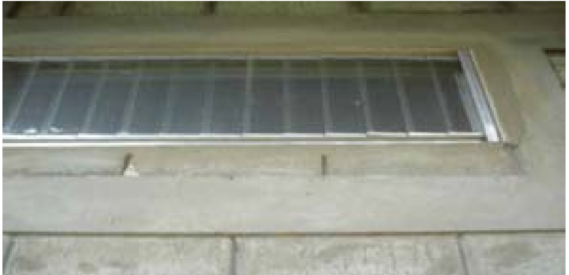
Figura No. 5. Ventanas protegidas con malla milimétrica.
