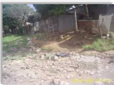
Foto N° 19: Vía en mal estado físico Fuente: Elaborado por Díaz, Jiménez y López, 2008
