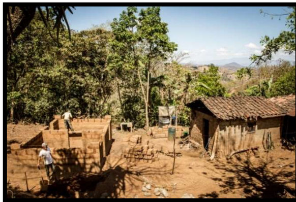
Ilustración 7-Construcción de casa de adobe en Jalapa
