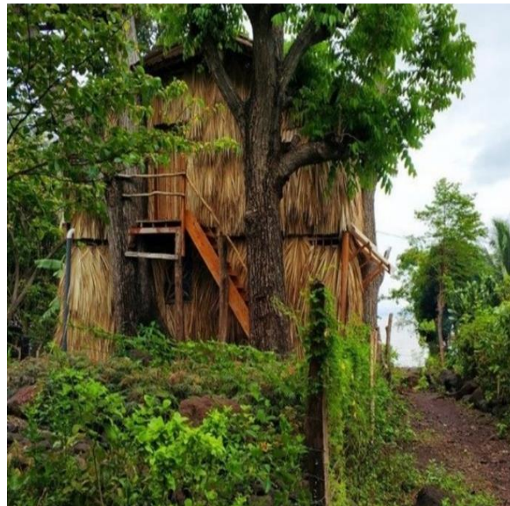
Ilustración 53: El bamboo tree house la Casa
