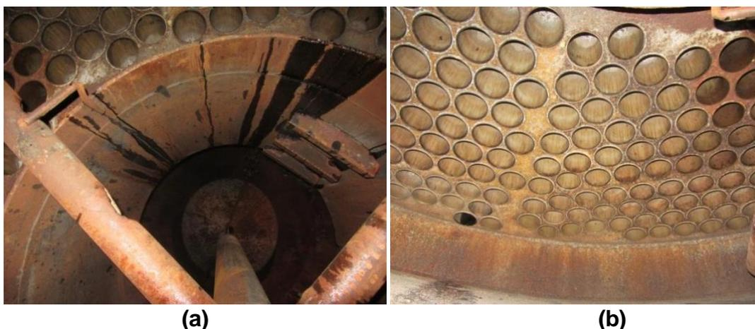
**Figura A.V.5.1** Fotografía de la parte interior de la calandria de un tacho del Ingenio Benjamín Zeledón (a) tubo central y (b) tubos fluse.
