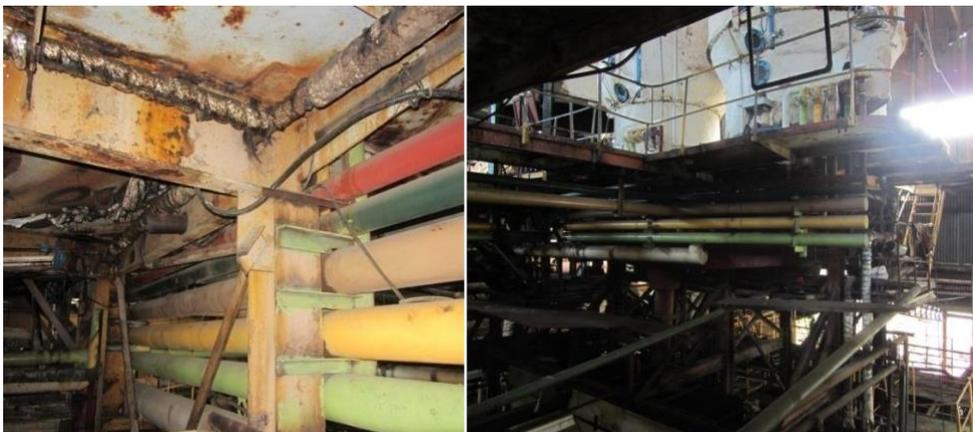
**Figura 5.3. Tuberías de alimentación a los tachos Marimba.**
