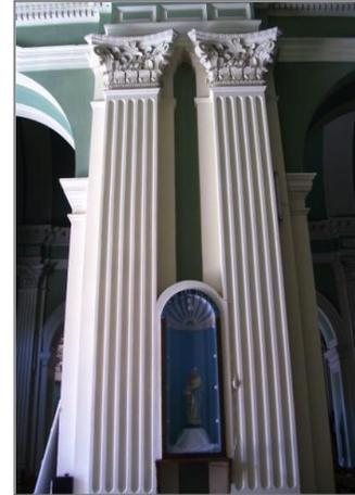
Ilustración nº 38 Vista de las Pilastras pareadas, estriadas
