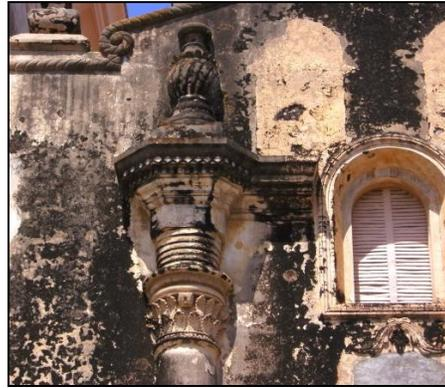
*Ilustración nº 73* Vista del deterioro en la pintura de la Fachada *Ilustración nº 74* Vista de la pérdida del color de la pintura
