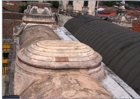
*Ilustración nº 58* Vista de la cubierta, compuesta por bóvedas de cañón corrido
