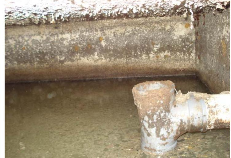
**Figura E-2** Afluente de cámara 1 del tanque séptico
