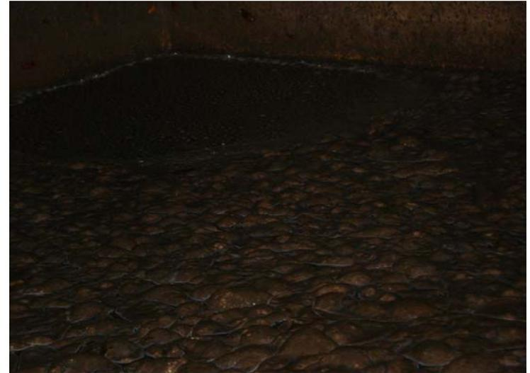
**Figura E-6** Nata de cámara 2 tanque séptico
