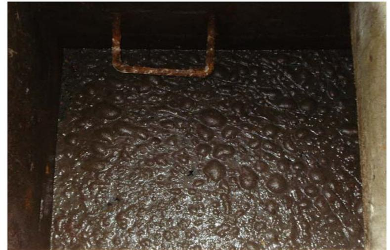
**Figura E-4** Agua en cámara 2 del tanque séptico
