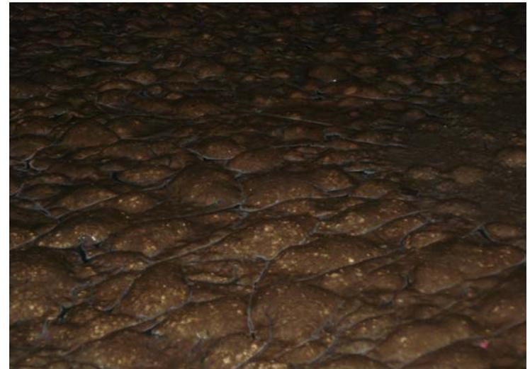
**Figura E-8** Nata de la cámara 2 del tanque séptico
