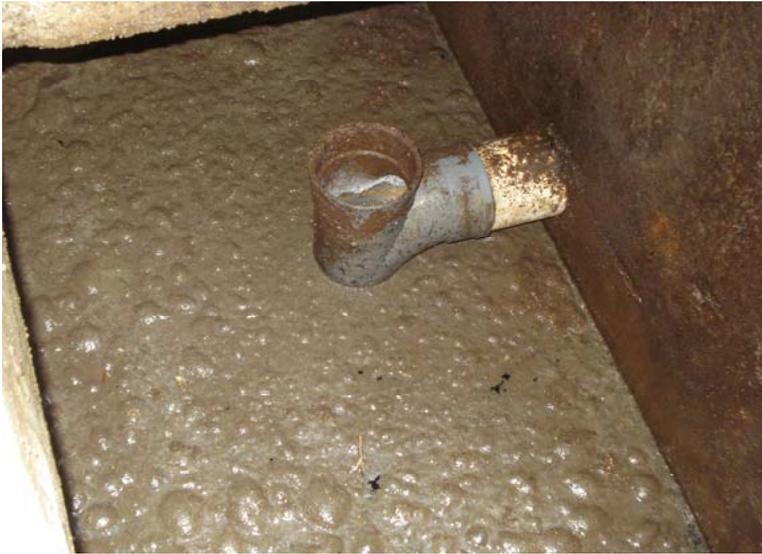
**Figura E-5** Afluente de la cámara 2 tanque séptico
