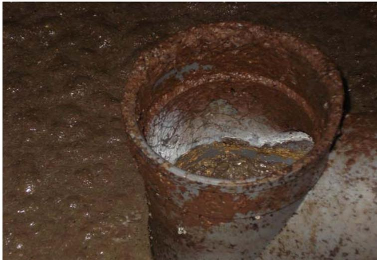
**Figura E-7** Tee del afluente cámara 2 del tanque séptico
