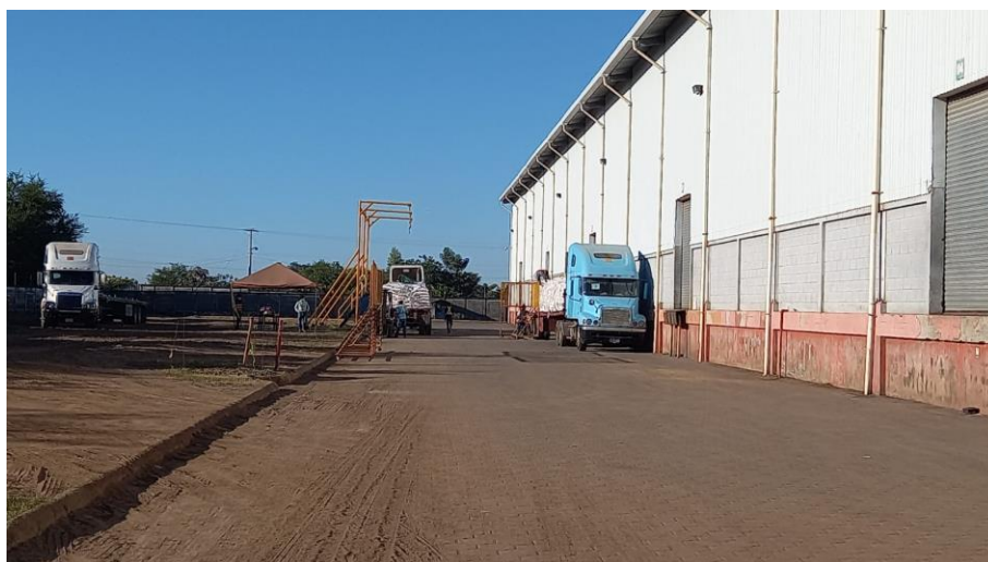
línea de carga Bodega Corinto #1
