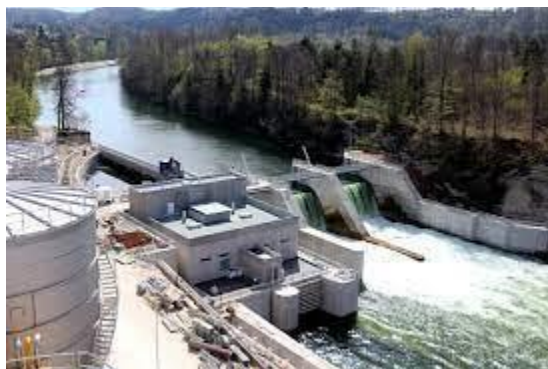
5-1 Central Hidroeléctrica Fuente: Pixabay
