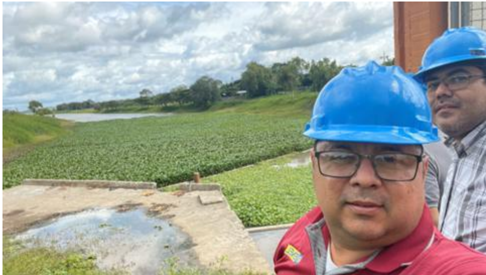
Canal de aducción (Cubierto de maleza acuática)
