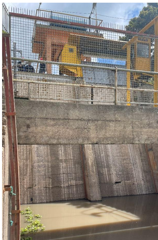
Compuerta entrada al túnel
