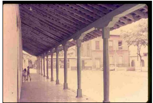
FOTO 25: VISTA DE LA CASA DESDE CASA CON CORREDOR PORTICADO
