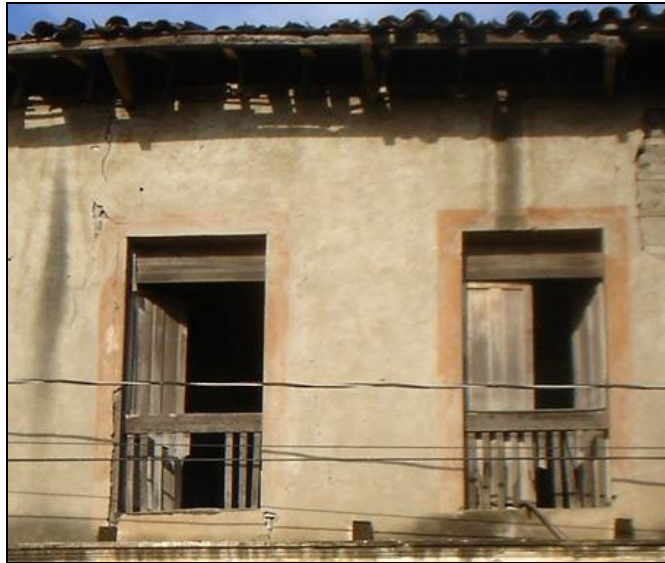
FOTO 48: TEJADO - VISTA OESTE
