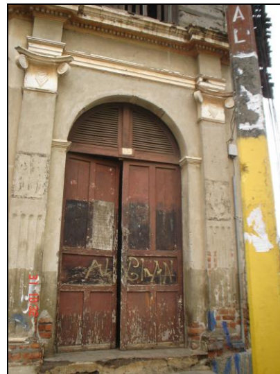
FOTO 37: DETALLES EN ACCESO PRINCIPAL
