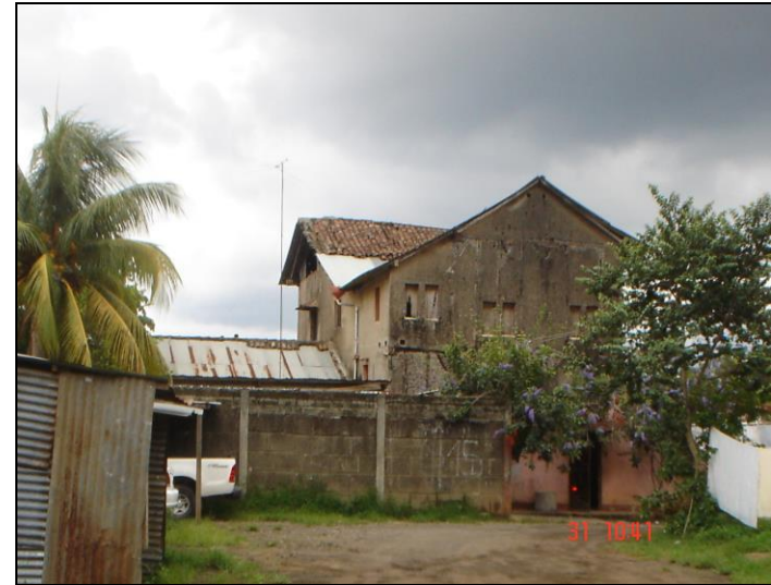
FOTO 49: TEJADO VISTA POSTERIOR (ESTE)
