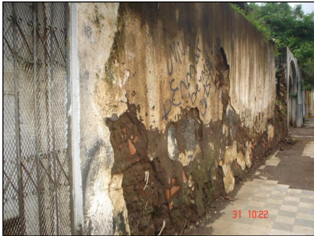
FOTO 50: VISTA LATERAL MURO DE ADOBE
