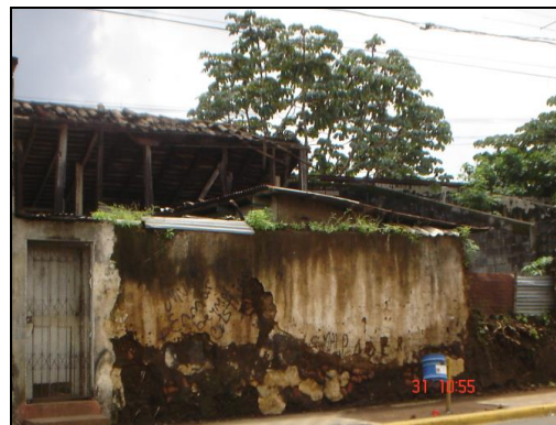
FOTO 40: MURO DE ADOBE-FACHADA OESTE
