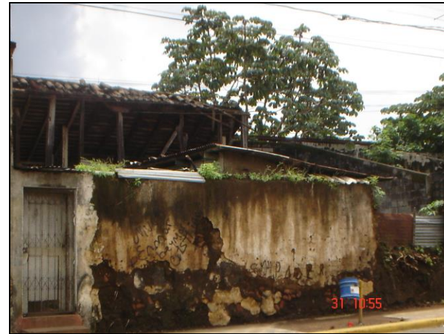
FOTO 51: VISTA FRONTAL MURO DE ADOBE
