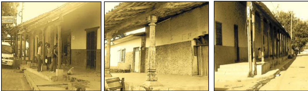
FOTO 14, 15 Y 16: GALERIAS PORTICADAS EN MASAYA
