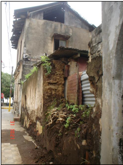
FOTO 57-ABERTURA EN MURO DE ADOBE
