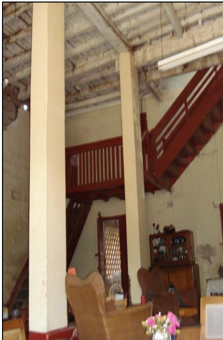
FOTO 46: ESCALERA DE MADERA
