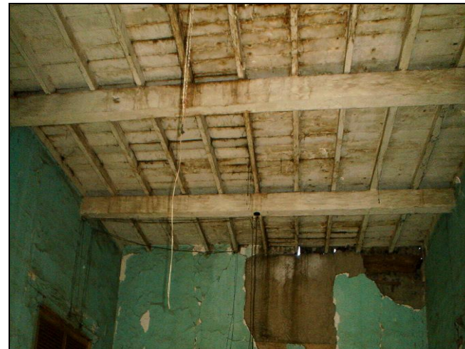
FOTO 47: ENTREPISO DE MADERA
