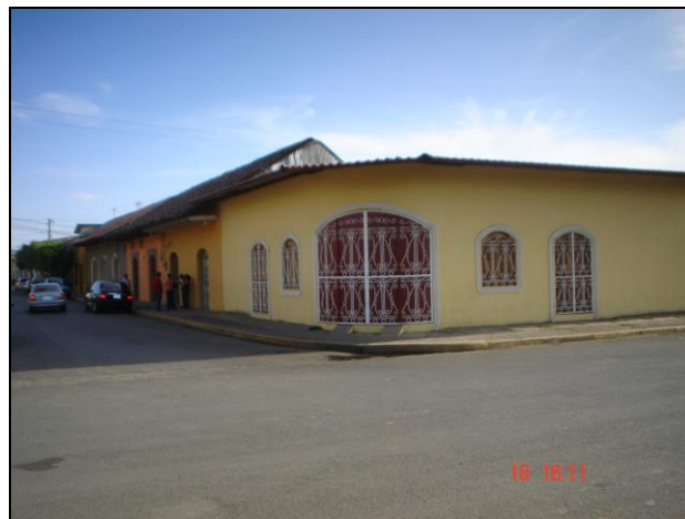
FOTO 31: VISTA DE LA INTERSECCION DE CALLES DESDE EL PARQUE
