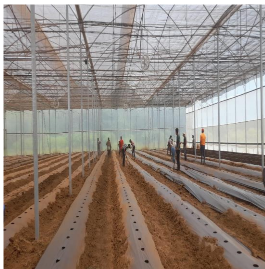
Figura 93. Instalación del plástico much
