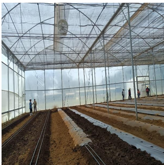
Figura 92. Instalación del sistema de riego de doble cinta
