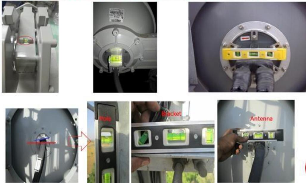
Figura No. 28 Configuración de Alineación de módulo OMT
