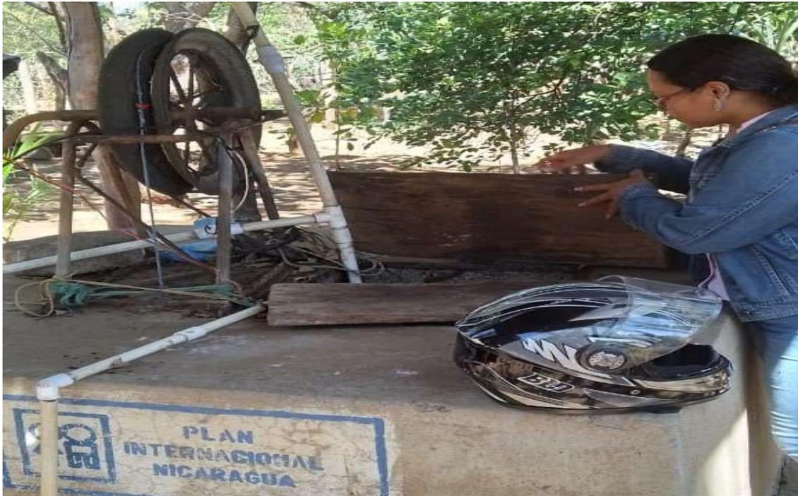
Figura No. 6: Pozo de agua con extracción por medio de polea. Fuente propia.
