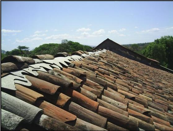
Foto 72. Cubierta de Tejas con Plycem en cumbre. Autor (2010).
