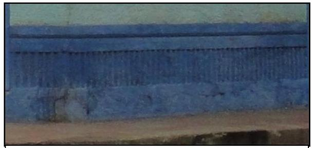
Foto 67. Zócalo con repello de mortero.
