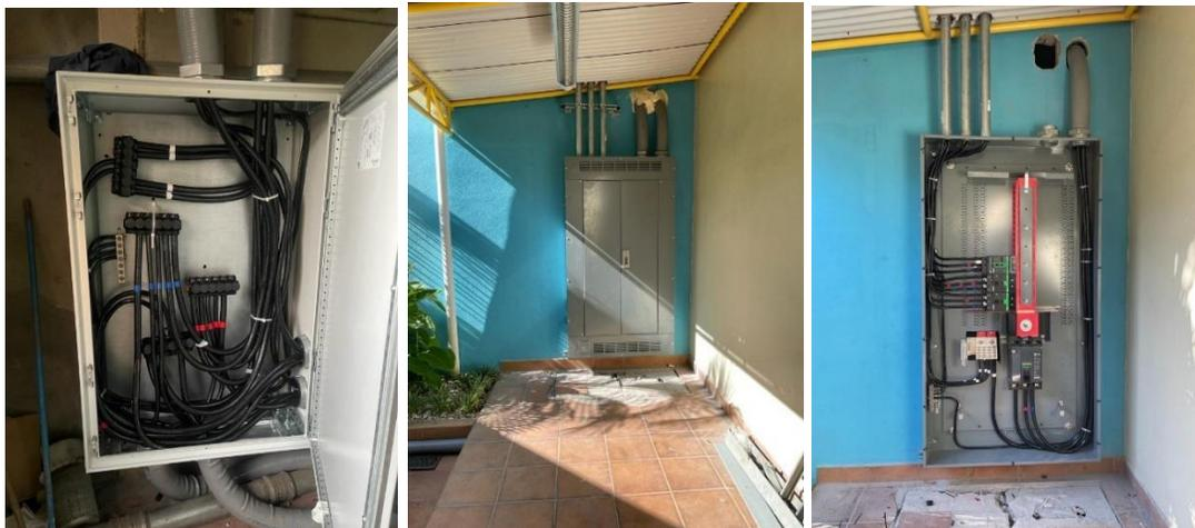
**Ilustración 9.** Interconexión planta solar fotovoltaico con el sistema eléctrico COALNIC
