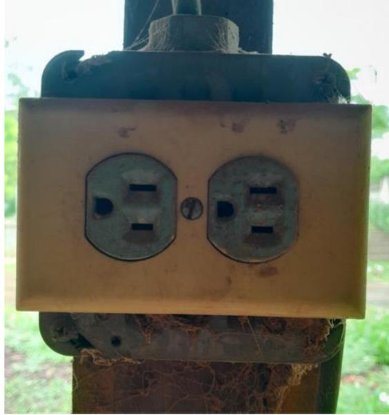
Figura 18: Tomacorriente sin terminales en caja de conexión
