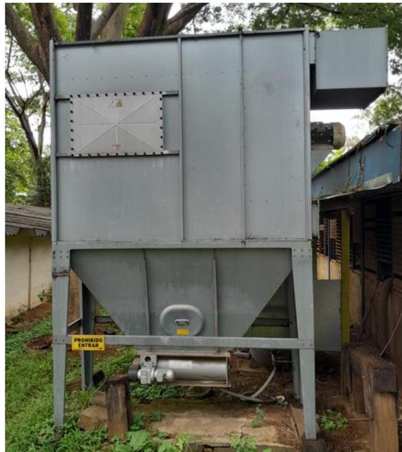
Figura 24: Sistema de extracción usado en la planta
