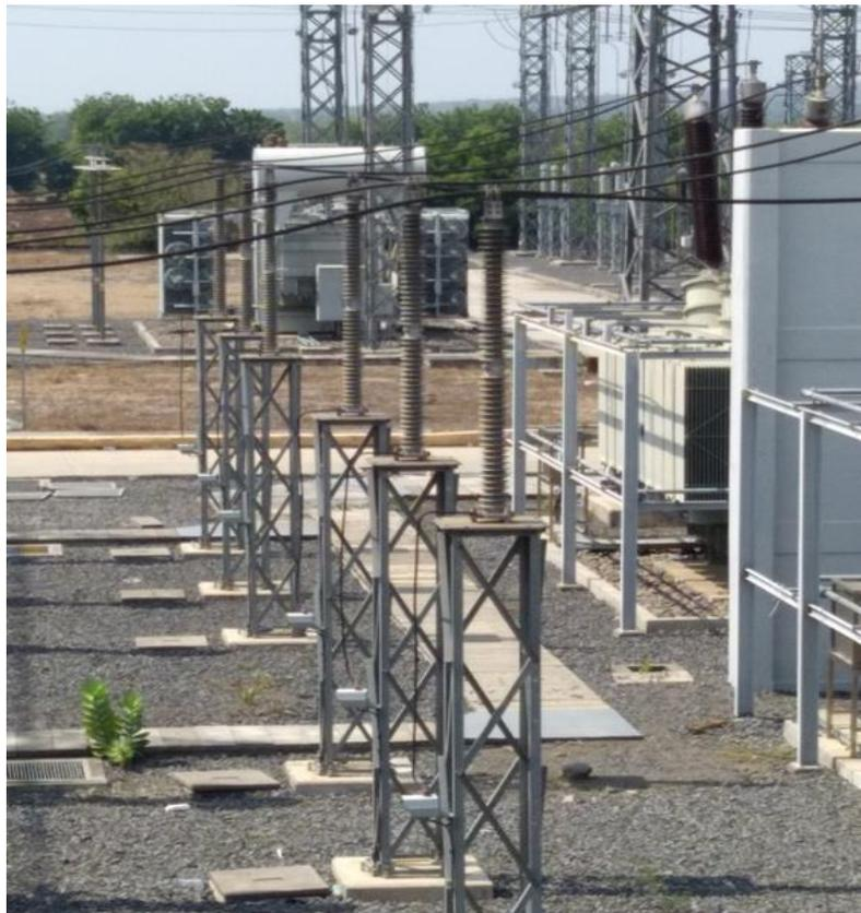
Figura No.9 Pararrayos Polimérico 230kV.
