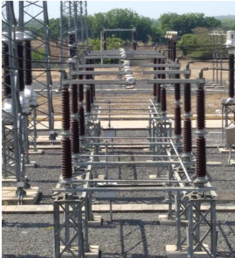
Figura No.8 Seccionador 230kV.
