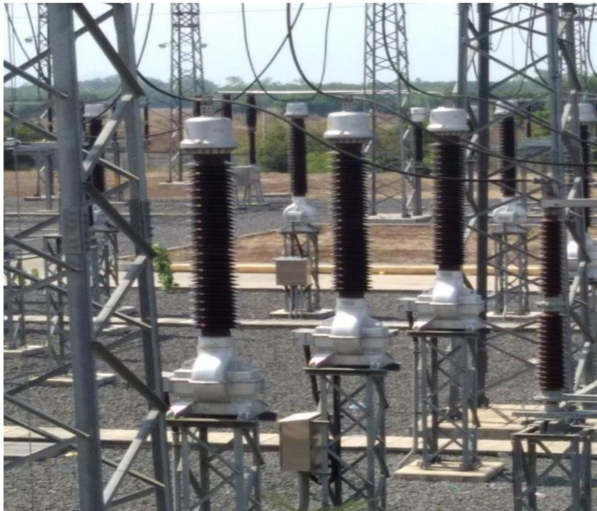
Figura No.7 Transformador de Potencial TP 230kV.
