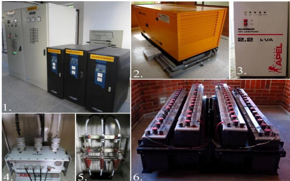
Figura No.13 1.Celdas de distribución de CD-AC y Cargador de baterías. 2. Grupo electrógeno o Planta de emergencia.3. Inversor. 4. Transformador de auxiliares. 5. Seccionador de auxiliares. 6. Banco de baterías.
