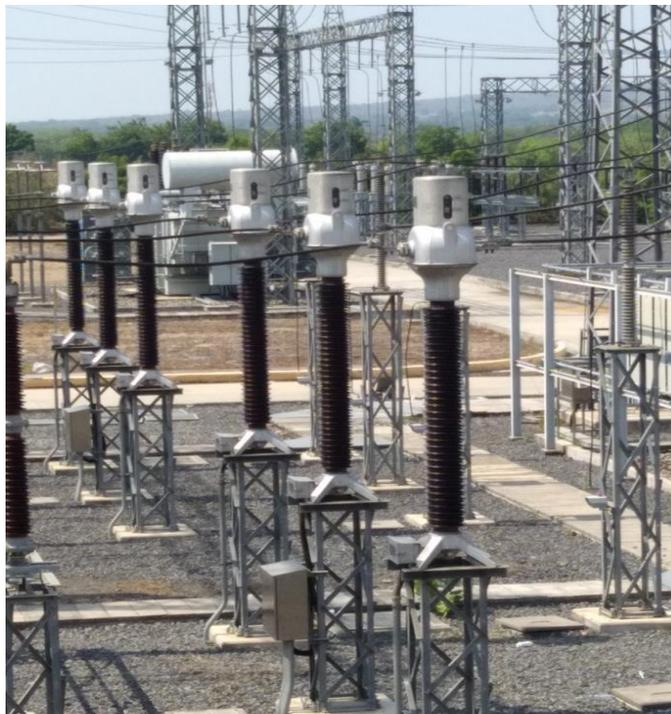
Figura No.6 Transformadores de Corriente TC 230kV.
