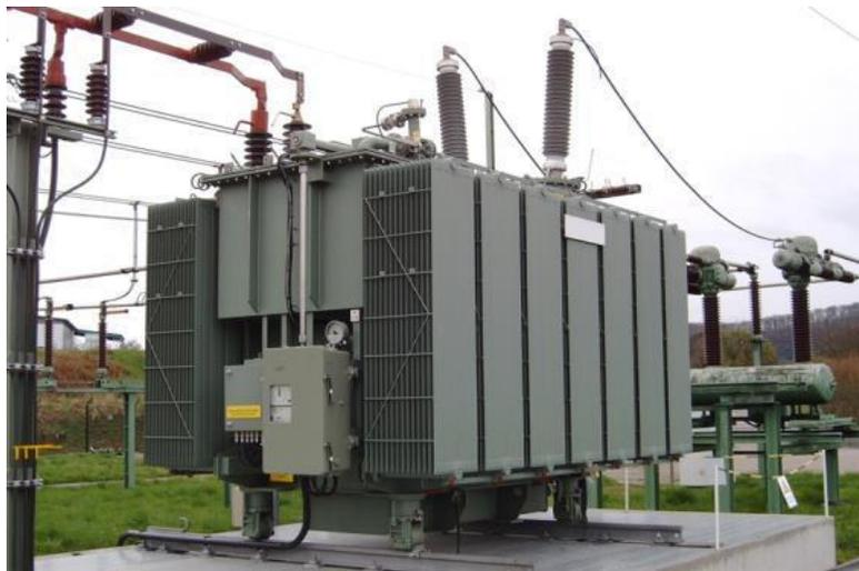
Figura No.3 Transformador de Potencia 138kV - 13.8kV.
