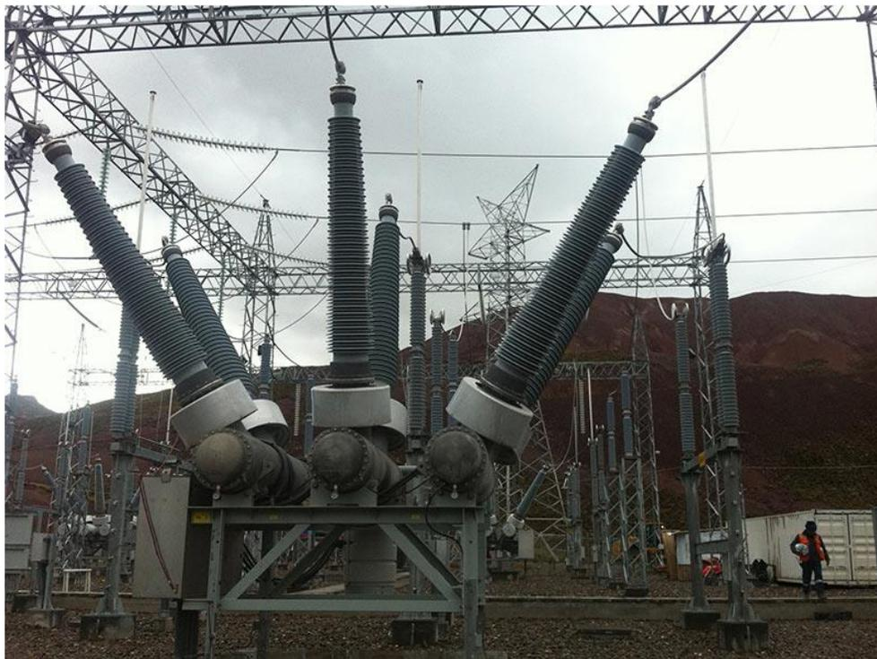
Figura No.5 Interruptor de Potencial, Acople 230kV.
