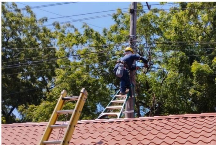
Figura 35: Técnico tensando fibra óptica
