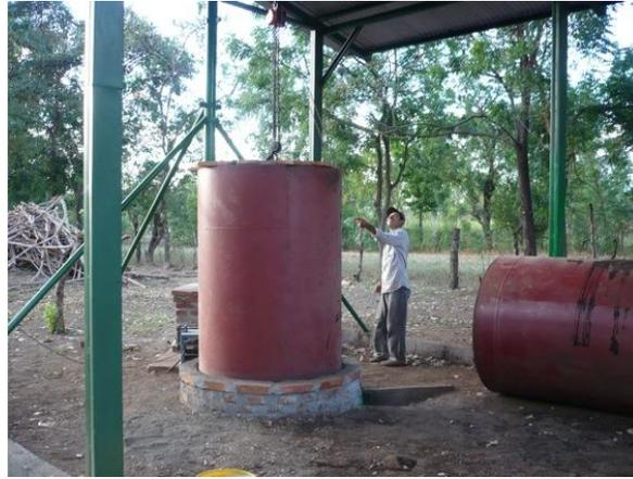
**Fotografía 7.** Horno Contenedor siendo montado sobre su base.
