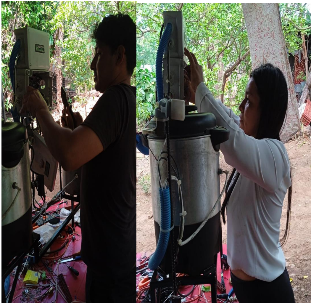
Montaje y cableado de los dispositivos de control Fuente: autoría propia
