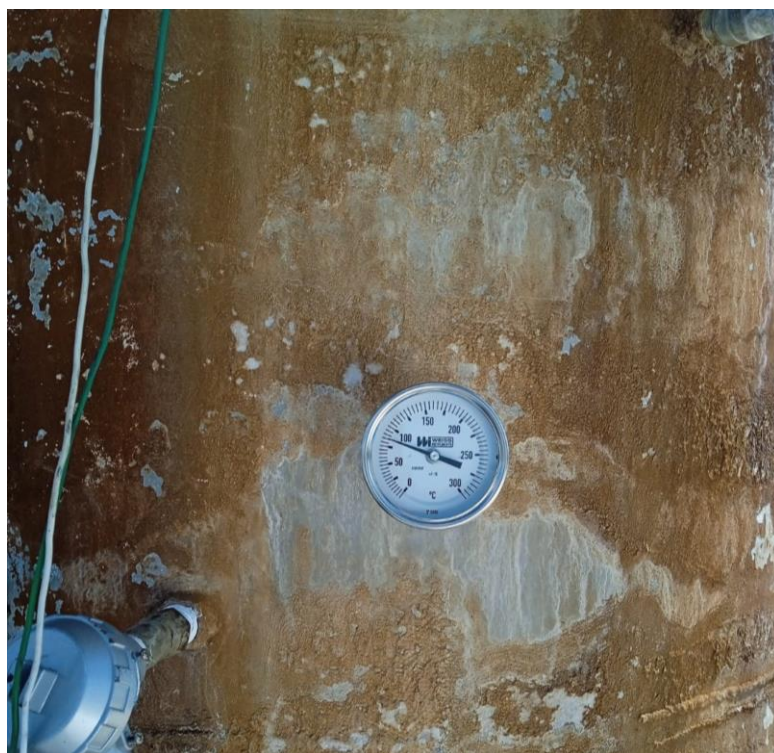
Monitoreo de temperatura en tanque de agua caliente Fuente: autoría propia
