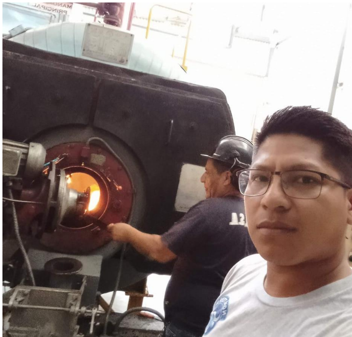
Operador de caldera planta Novaterra, S.A. Fuente: autoría propia
