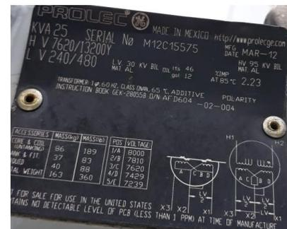
Fotografía 14: Placa de datos de Transformador T4.3
