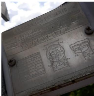
Fotografía 37: Placa de datos de Transformador T11.2
