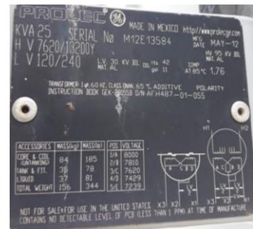
Fotografía 26: Placa de datos de Transformador T8.3
