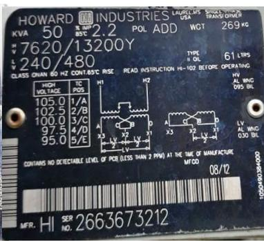
Fotografía 43: Placa de datos de Transformador T13.2
