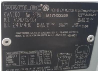
Fotografía 20: Placa de datos de Transformador T7.1
