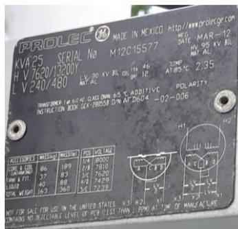
Fotografía 13: Placa de datos de Transformador T4.2
