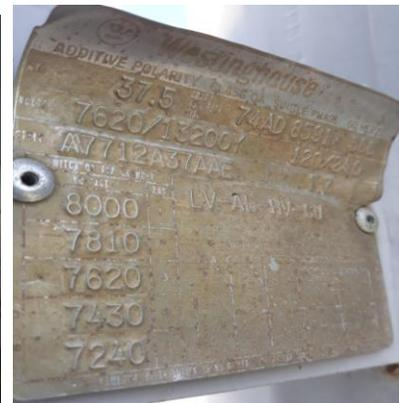
Fotografía 38: Placa de datos de Transformador T11.3
