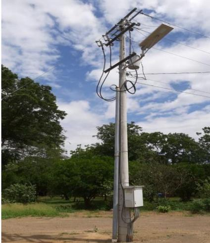
Fotografía 39: Punto de conexión a la red del sistema de generación fotovoltaica de Centro de transformación T12.
