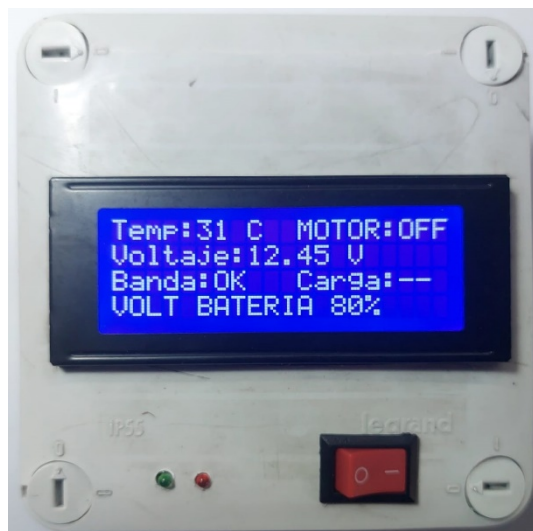
Imagen 41 – Condición auto apagado, simulación de batería al 80% de capacidad y banda OK.
