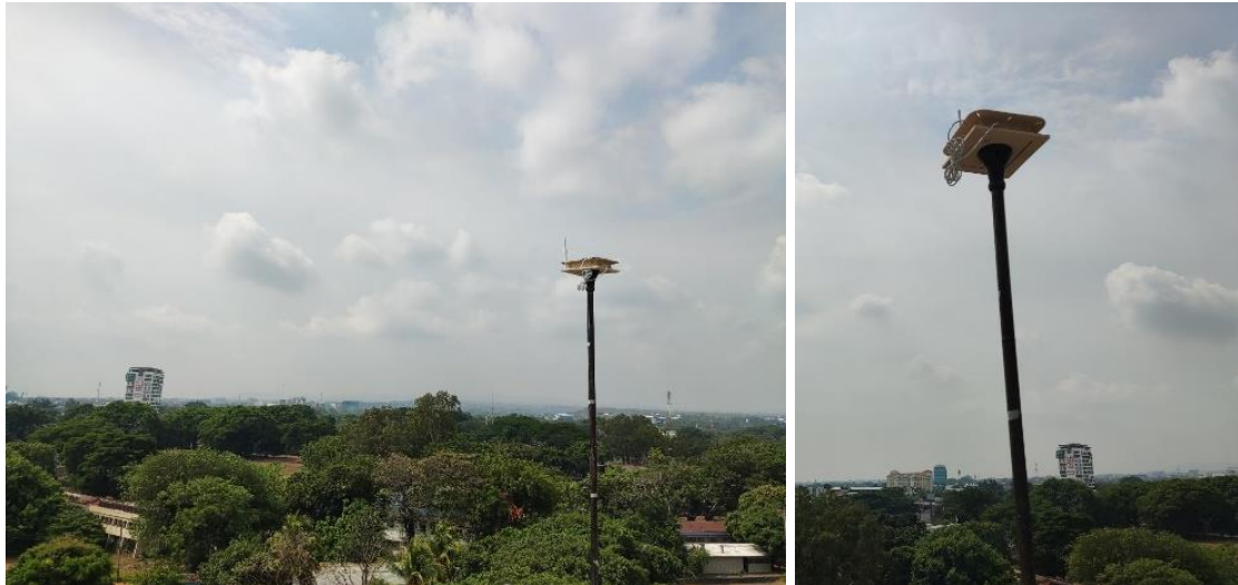
Figura 63. Gateway en azotea del Edificio Rigoberto López Pérez [Autor].
