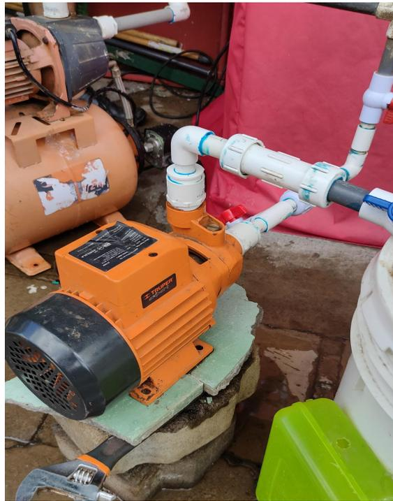
**Figura 6.2.** Bomba de agua de 1 HP
