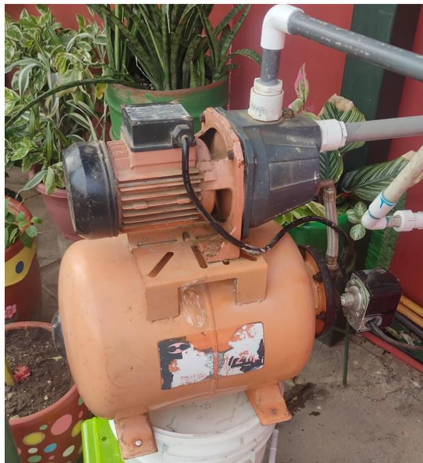
**Figura 6.1.** Bomba de agua de  $\frac{1}{2}$  HP
