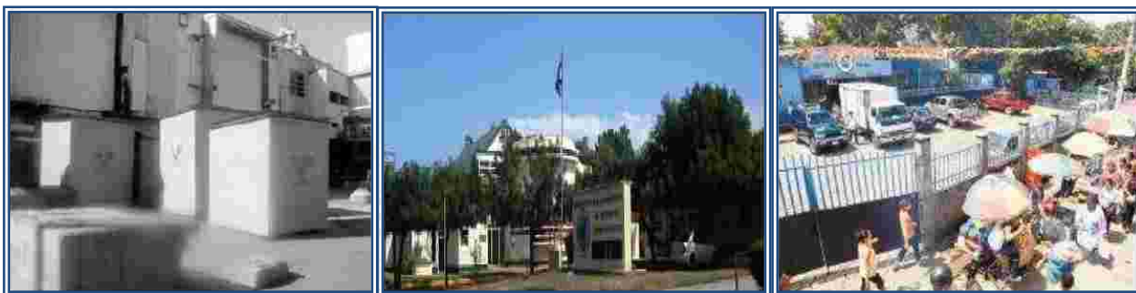
1. Planta Eléctrica Managua
