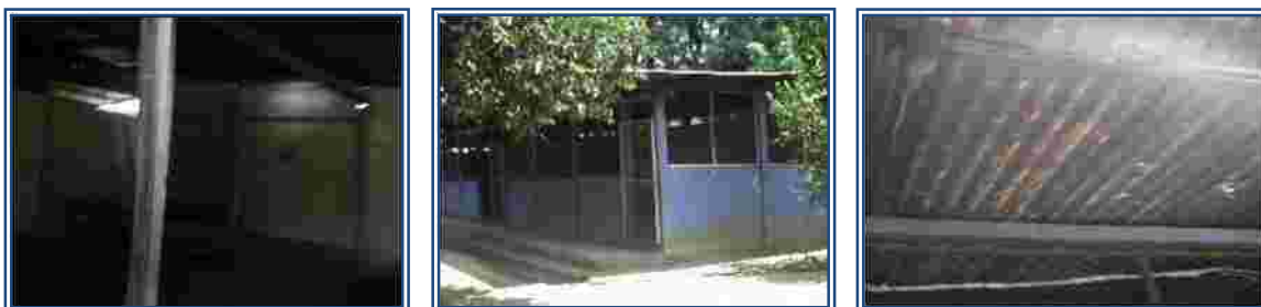
Fotografía No.43: Estado Físico Colegio San Pablo
