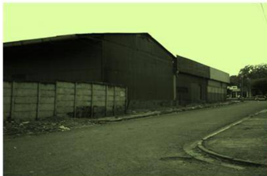
Situación Actual-Industrias en Abandono Asentamiento Benedicto Valverde (Quinta Nina)
