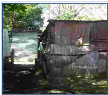
Fotografía No.3: Sistema de AHE's Fuente: Alcaldía de Managua.
