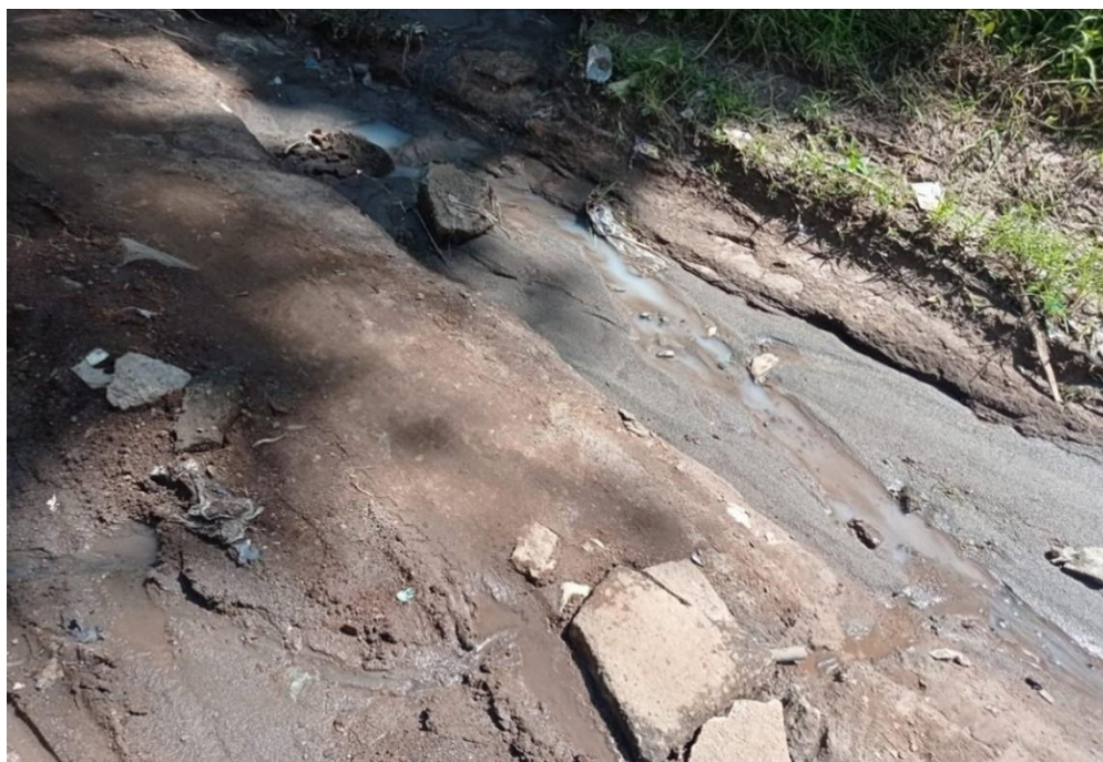
Figura 2: Sedimentos en el tramo
