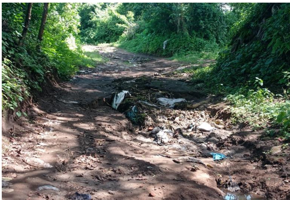
Figura 1: Estado Actual del tramo
