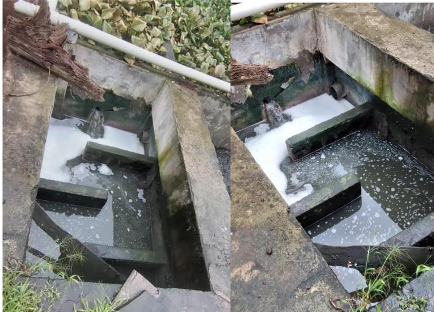
El caudal medio es de 2.20 l/s, el agua ya es tratada, se propone una dosis de 5 mg/l, como promedio de lo requerido por el efluente de una zanja de oxidación. Se utilizará hipoclorito de calcio en forma de pastilla colocándolo en el punto de entrada a la estructura de desinfección.
