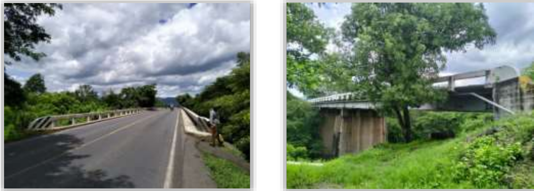
Figura 14: Drenaje mayor, puente de paso río viejo (km 108.730)
