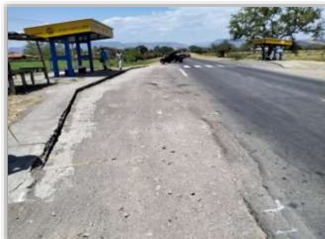
Figura 32: Bahía de buses km 108.263, carril izquierdo (sentido sur-norte)
