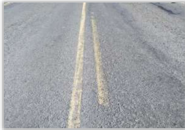
Figura 25: Línea doble combinada localizada en el km 110.000; en estado regular
