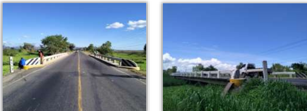
Figura 15: Drenaje mayor, puente el Zanjón blanco (km 112.970)
