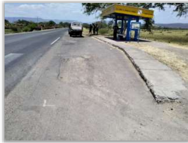
Figura 33: Bahía de buses km 108.285, carril derecho (sentido sur-norte)
