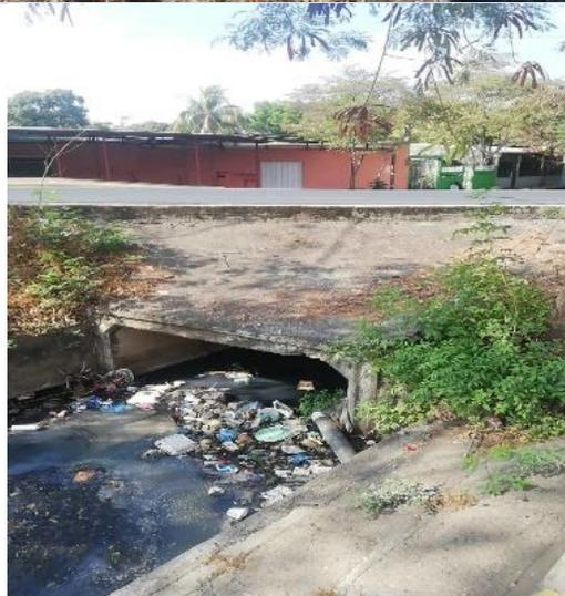
En el tramo se localiza una caja puente que funciona para la circulación de las aguas pluviales provenientes de aguas arriba del cauce de la zona y así no obstruir el paso vehicular, se encontró en regular estado y se observó la presencia de basura y circulación de aguas grises
