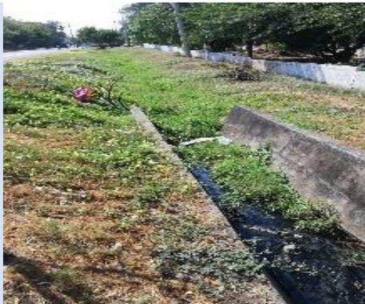
Se encontraron cauces naturales con algunas secciones revestidas, esto para evitar la excesiva erosión del suelo y la posible inestabilidad de los taludes de la vía.
