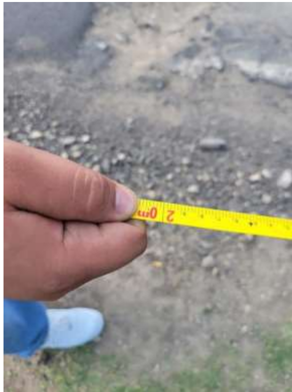
Figura 82: Medición de alineamiento horizontal para topografía
