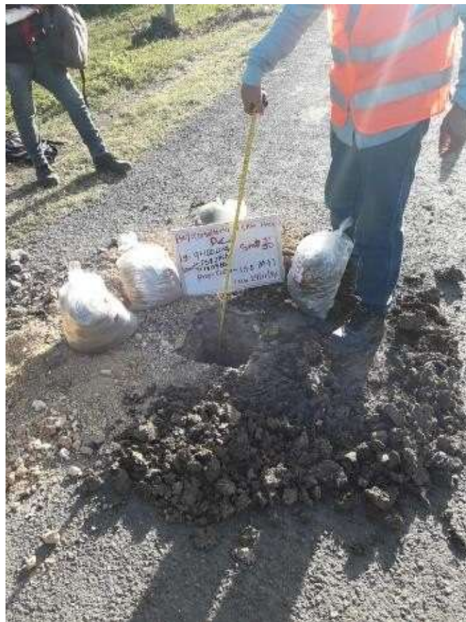
Figura 70: Sondeo para estudio de suelo (Parte 2)
