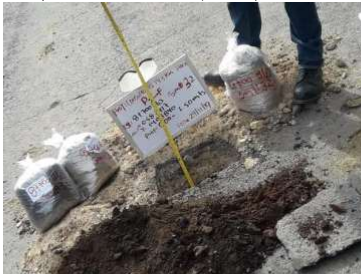
Figura 69: Sondeo para estudio de suelo (Parte 1)
