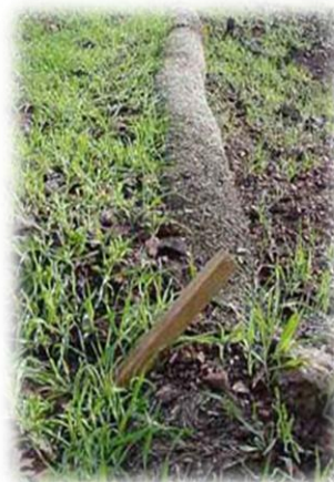
Foto 38: Biorrollos instalados
