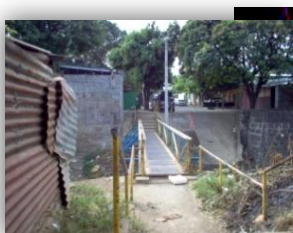
Foto 10: Puente peatonal Fuente: Propia. 2008
