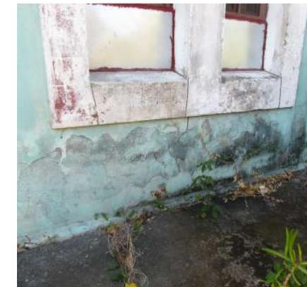
Figura 159: Desprendimiento de material y eflorescencia.
