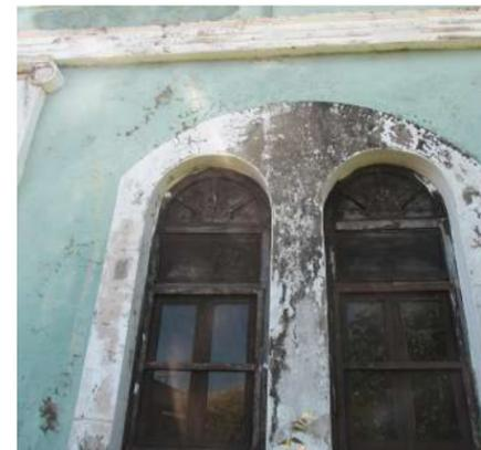
Figura 158: Pátinas y fisuras.
