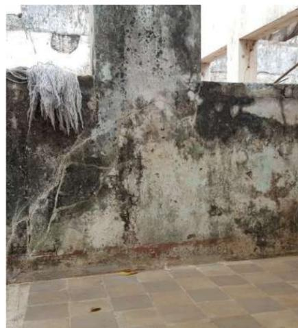
Figura 183: Pátinas, erosión y humedad en muro de corredor R01.
