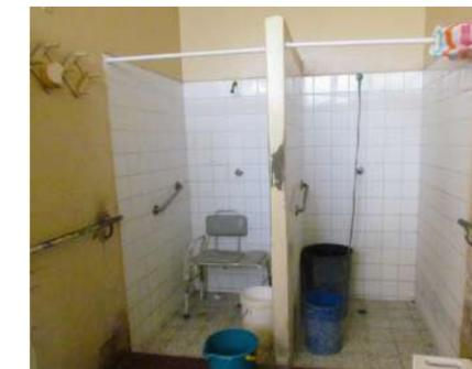
Figura 151: Acumulación de suciedad en piso y bases de muros. (149)
