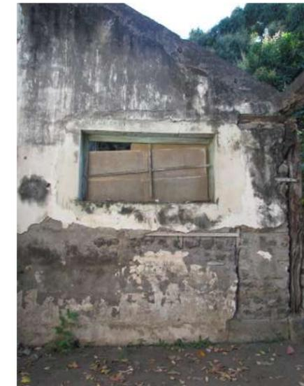
Figura 196: Pátinas, desprendimiento de material y erosión.
