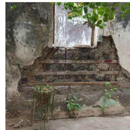
Figura 122: Taquezal expuesto.
