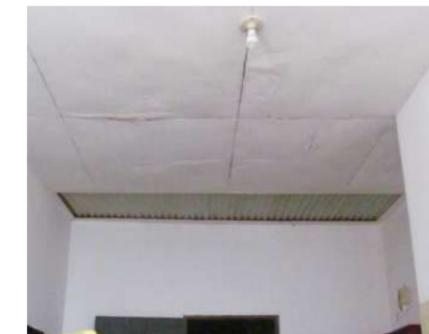
Figura 152: Humedad por filtración en cielo falso. (150)
