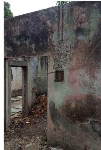
Figura 199: Pátinas y desprendimiento de material.
