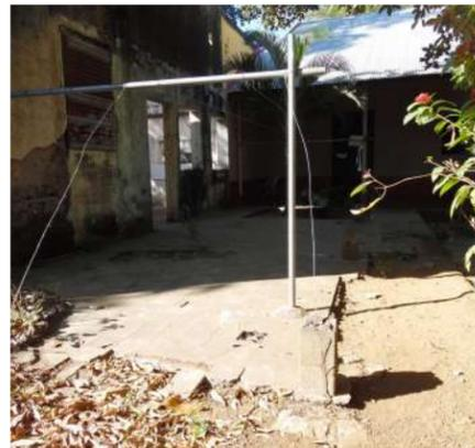
Figura 185: Ausencia de piso y pórtico del corredor R01.
