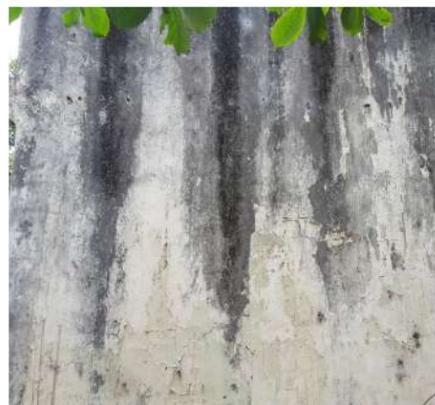
Figura 192: Erosión y suciedad por lavado diferencial.
