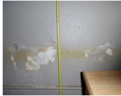
Figura 149: Desprendimiento de pintura por roces con el mobiliario. (148)
