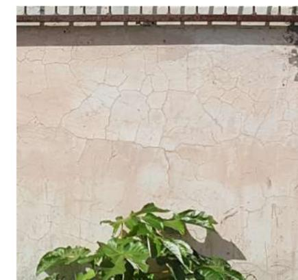
Figura 169: Fisuras. Fachada A-B5.
