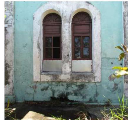
Figura 155: Erosión meteorológica y pátinas.
