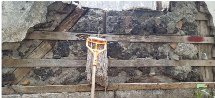
**Figura 217:** Construcción de Taquezal, técnica constructiva utilizada a inicios del siglo XX.
