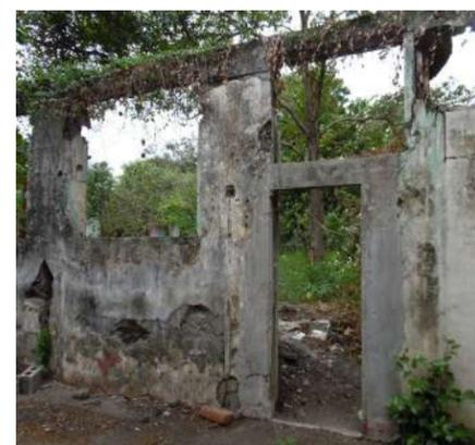
Figura 195: Ausencia de carpintería de puertas y ventanas.
