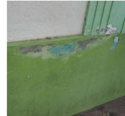
**Figura 181:** Desprendimiento de capa de pintura y eflorescencia, fachada norte.
