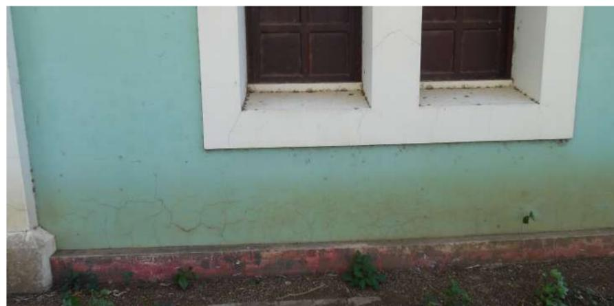
Figura 136: Fisuras en base de muro y jamba de ventana, fachada A-B1
