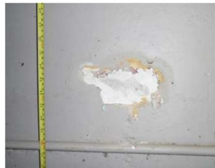
Figura 148: Desprendimiento de pintura por roces con el mobiliario. (148)
