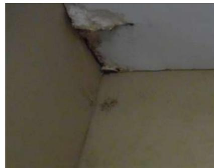
Figura 146: Desprendimiento de cielo falso. (145)
