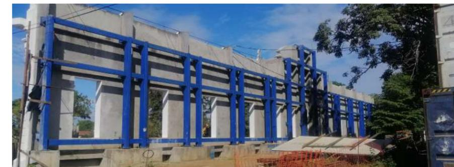
Figura 32: Fachada posterior de muro histórico después de la restauración.
