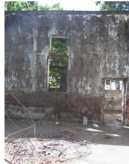
Figura 191: Pátinas, desprendimiento de material y erosión.
