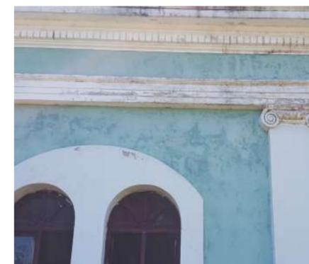
Figura 144: Humedad por filtración en fachada A-B2.
