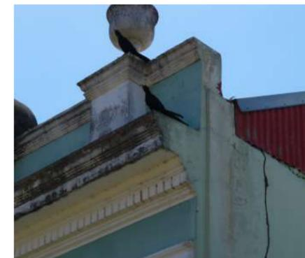
Figura 142: Erosión y pátina en cornisa de fachada A-B2.
