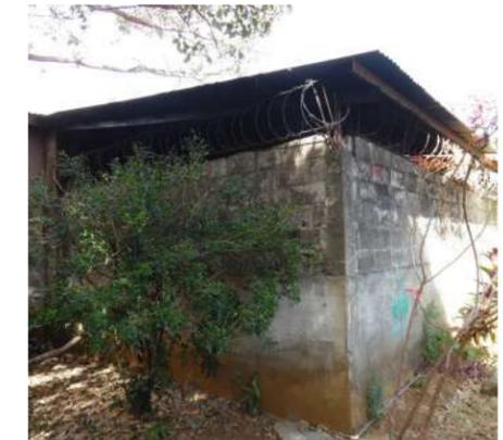
Figura 168: Humedad por capilaridad en base de muro en fachada A-B5.
