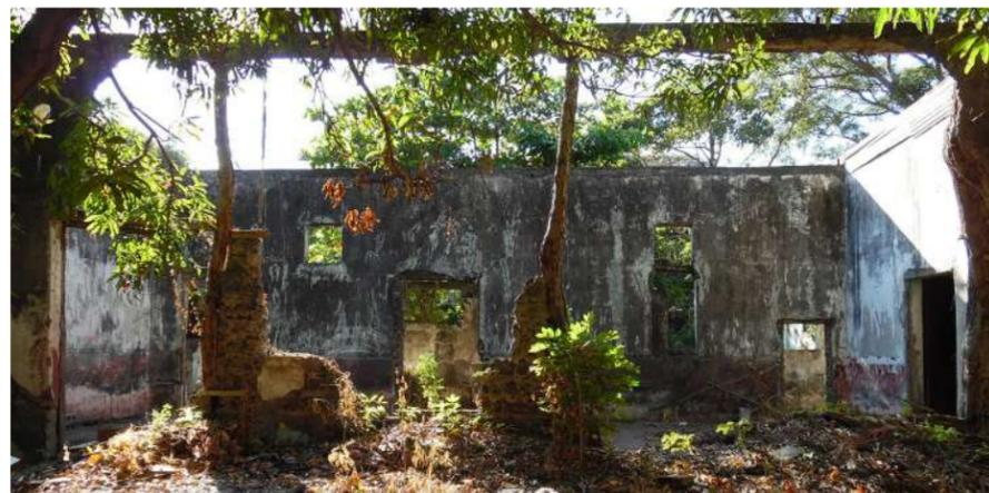
Figura 187: Sección de muro colapsada, corredor R01.
