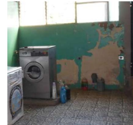
Figura 163: Desprendimiento de pintura en muro. (167)
