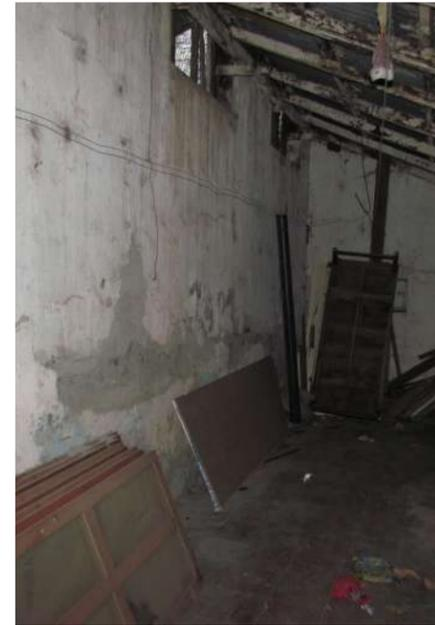
Figura 201: Desprendimiento de material y mal estado de estructura de techo.
