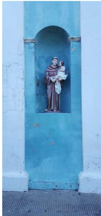
Figura 154: Humedad por capilaridad. Fachada AB-2.
