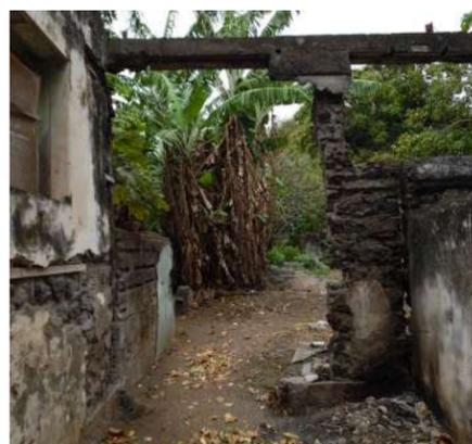
Figura 194: Colapso en perímetro de boquetes de puertas y ventanas.
