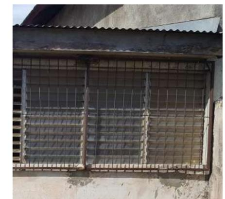
Figura 170: Oxidación en verjas de ventana. Fachada A-B5.
