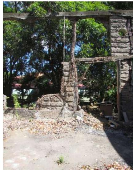
Figura 190: Desplome de muro.
