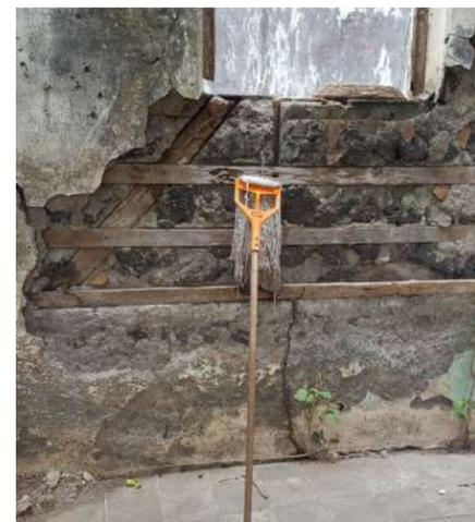
Figura 184: Desprendimiento del material de recubrimiento del muro del corredor R01.
