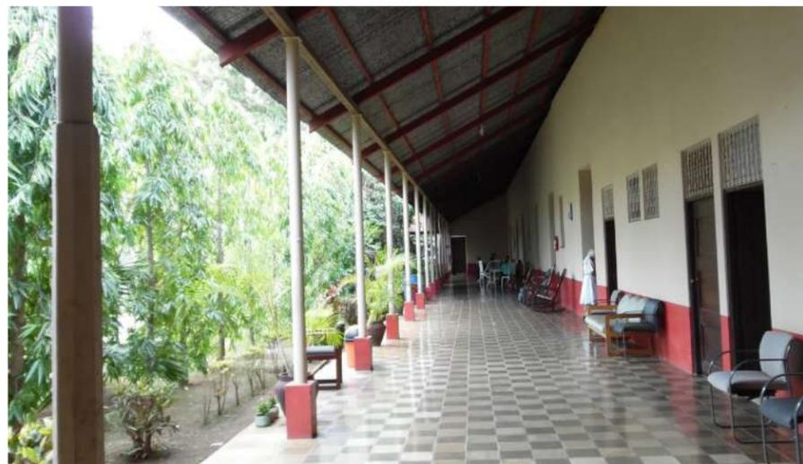
Figura 128: Sustitución de columnas y estructura de techo en pasillo. (102)
