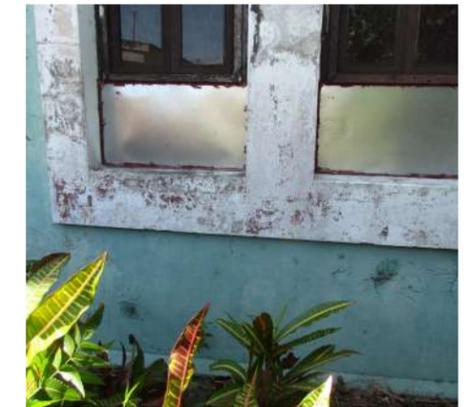
Figura 157: Alteración de ventanas y erosión.
