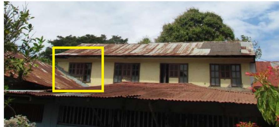
Figura 236: Fachada sur de capilla. Contacto de ventana con cubierta de techo.
