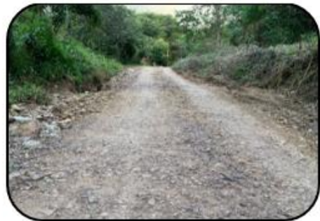
Foto 4. Final del tramo (Est. 2+000).
