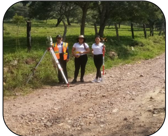
Foto 18. Cuadrilla de levantamiento.
