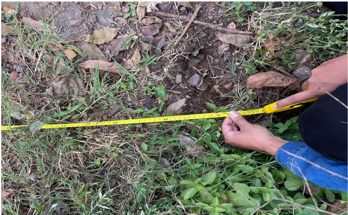
Foto 19. Ancho de actual de la vía (7.00 metros)
