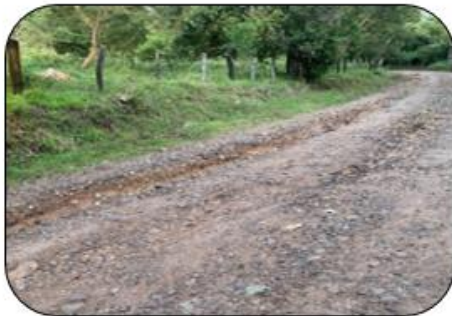
Foto 2. Desgaste de la superficie de rodamiento (Est. 0+60).
