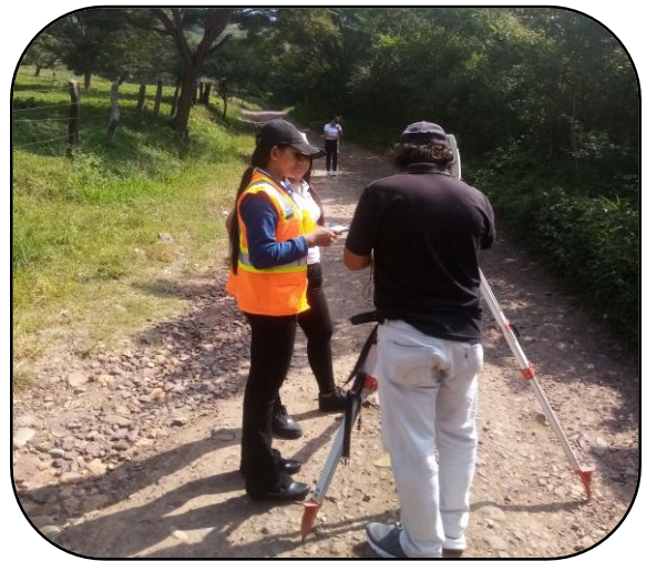
Foto 14. Levantamiento a cada 20 metros.
