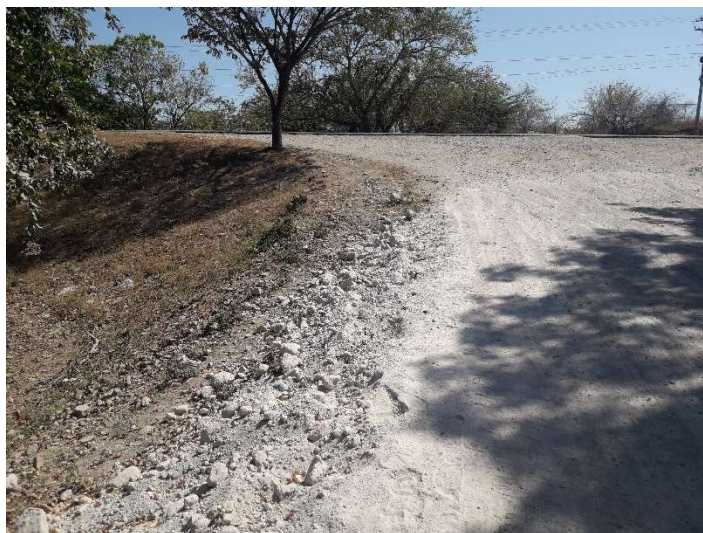
Figura 13: Inicio del tramo Empalme Larreynaga (Est. 0+000)
