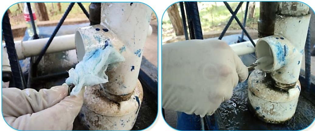
**Figura 4.7.** Desinfección de la boca de la tubería de salida del pozo comunitario “La Corona”.
