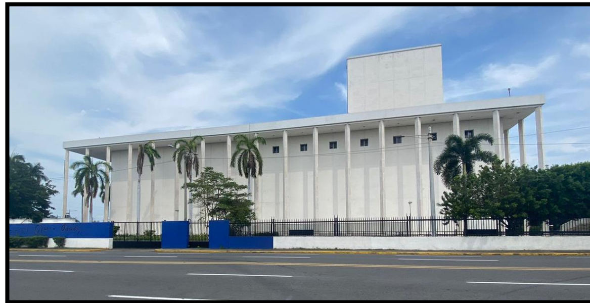
Figura 156: Vista lateral del Teatro Nacional
