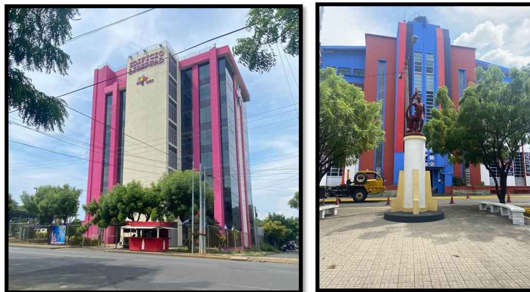
Figura 157: Vista Frontal del Edificio INSS y el Palacio de la Comunicaciones.
