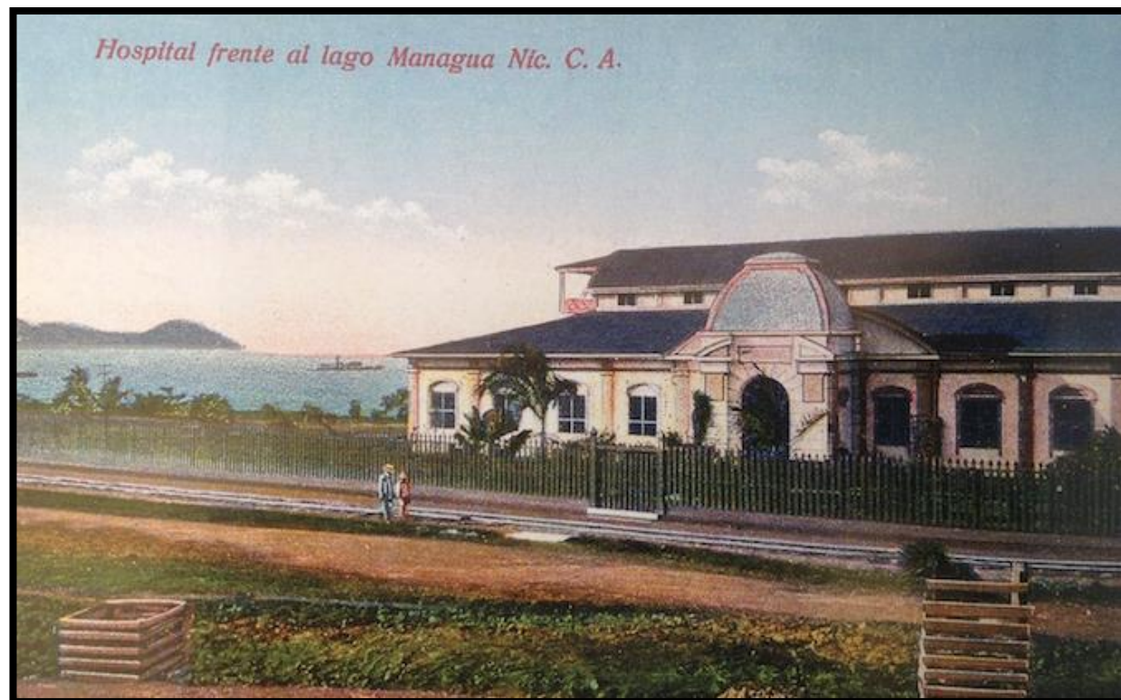
Figura 49: Hospital frente al Lago de Managua (c. 1900)
