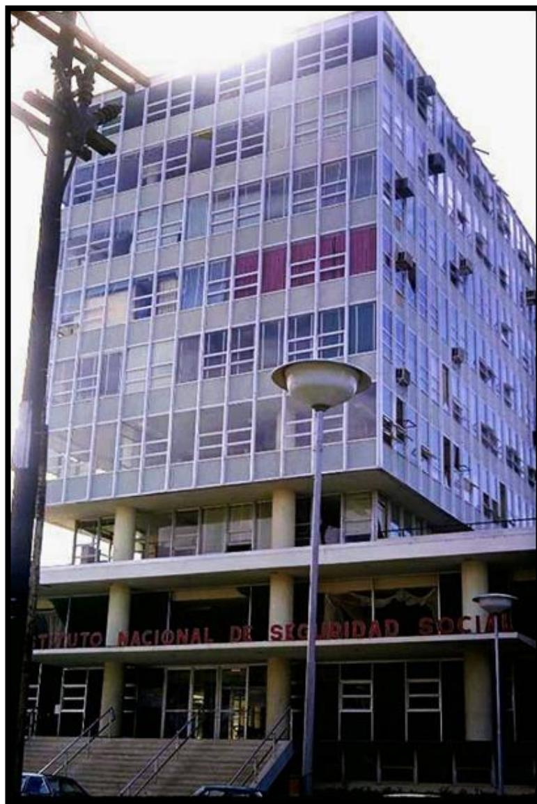
Figura 123 Fotografía de cómo se veía anteriormente el edificio INSS
