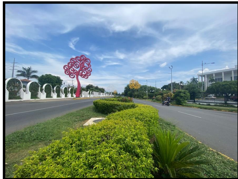
Figura 152: Vista de la Carretera Panamericana Norte.
