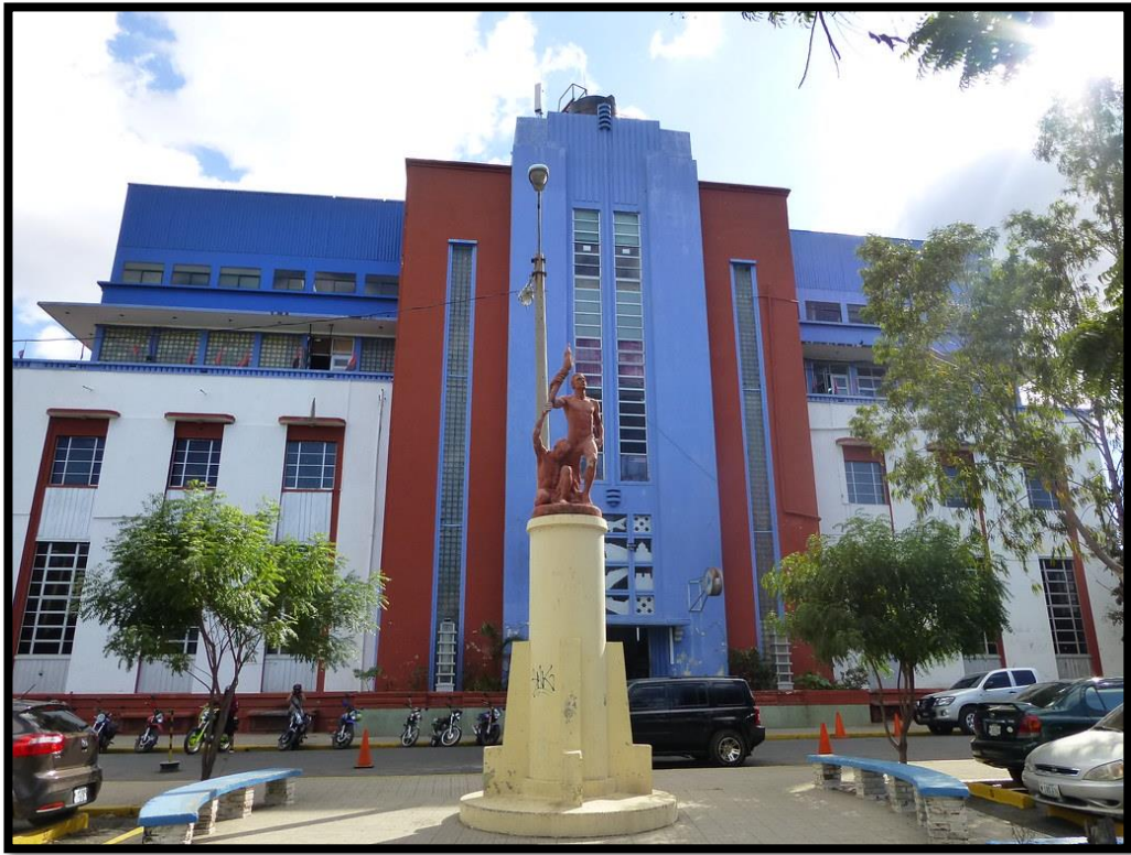
Figura 91 Palacio de comunicaciones antes de que se cambiara su pintura.
