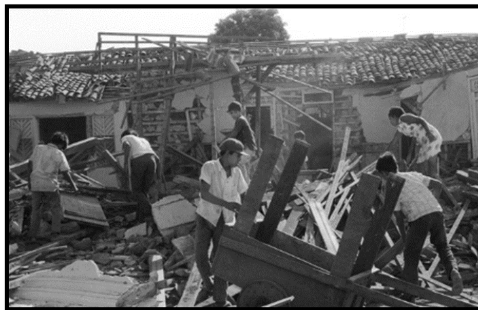
Figura 144: Daños por terremoto Managua Nicaragua 1972.
