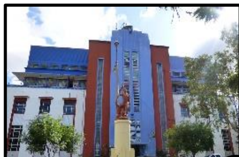
Palacio de Comunicaciones
