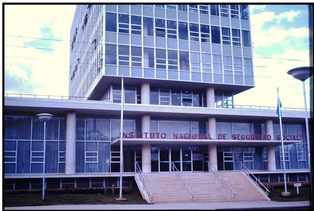
Figura 121 Edificio Administrativo del INSS - Managua D.N.
