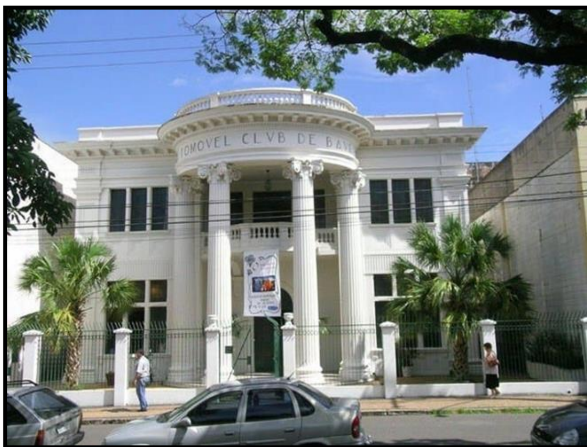
Figura 104: Edifício do Automóvel Clube de Bauru, São Paulo, Brasil.
