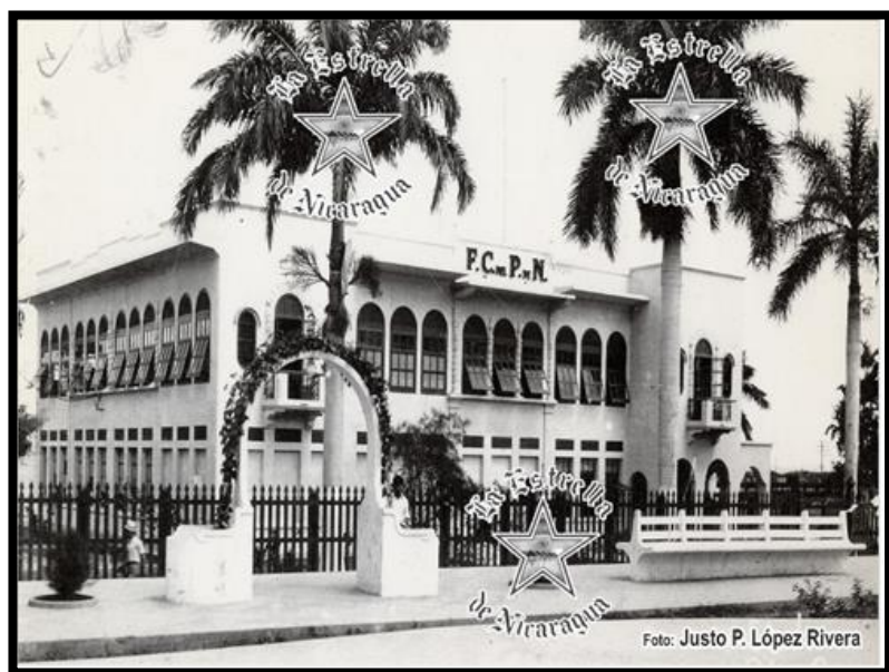
Figura 69 Oficinas Generales del Ferrocarril del Pacifico de Nicaragua (F.C. del P. de N.)
