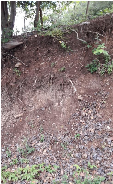
Foto N.16: Vista de Fallas, municipio de Juigalpa
