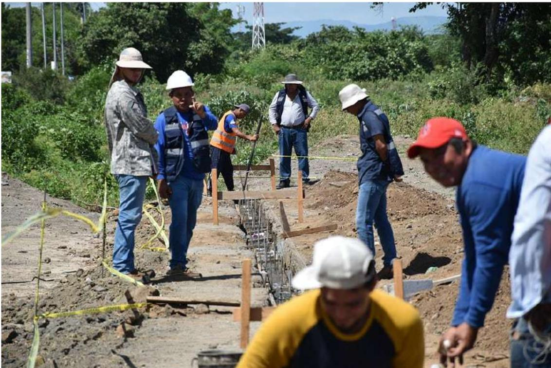
Fotos de actividades fundición de viga asísmica, proyecto en el cual soy supervisor.
