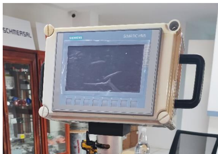
Figura 49. Montaje de HMI
