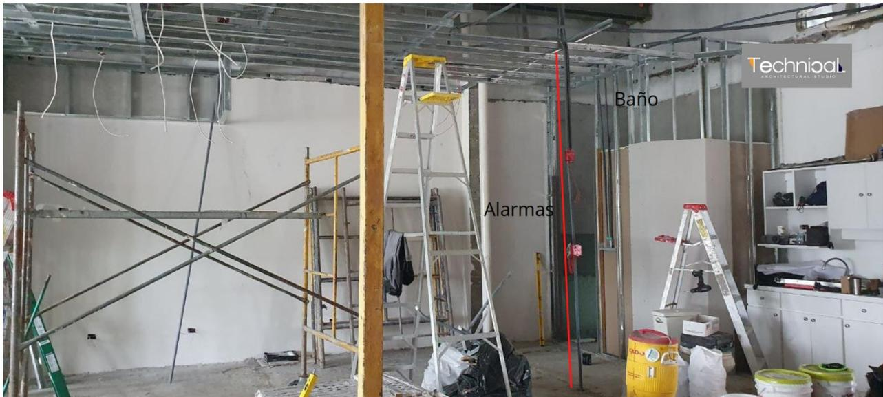
El baño, en estructura, se terminó de instalar y se empezó a laminar en base a la última modificación sugerida. Alarmas debe reubicar la tubería señalada para que no obstaculice la entrada a la bodega. Por otra parte, redes realizó sus primeras instalaciones, se nos dijo que se le notificara cuando se termine de laminar el cielo.
