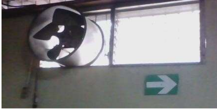
Ilustración 39 Ventana de área de empacad.
