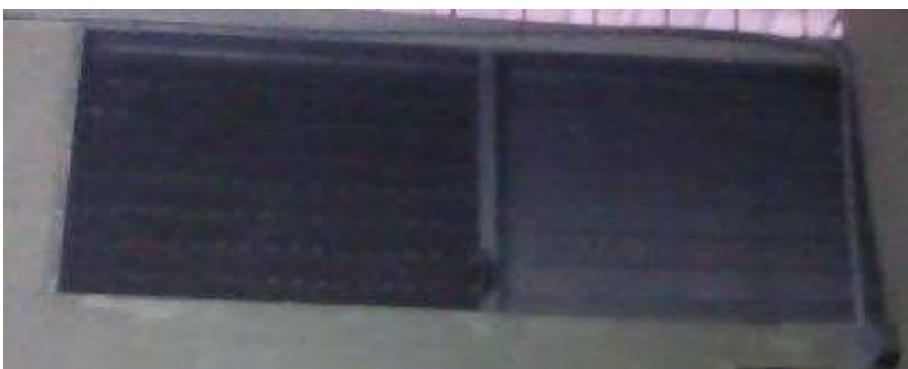
Ilustración 37 ventanas de área de molienda.
