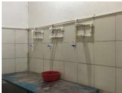
Figura 8 y 9: Paredes del área de llenado
