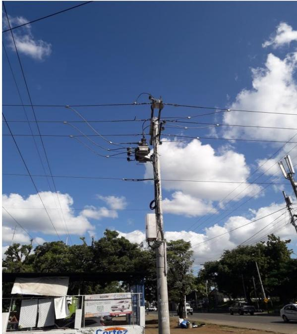
Interruptor telecontrolado con caja de control instalado en poste 35 pies
