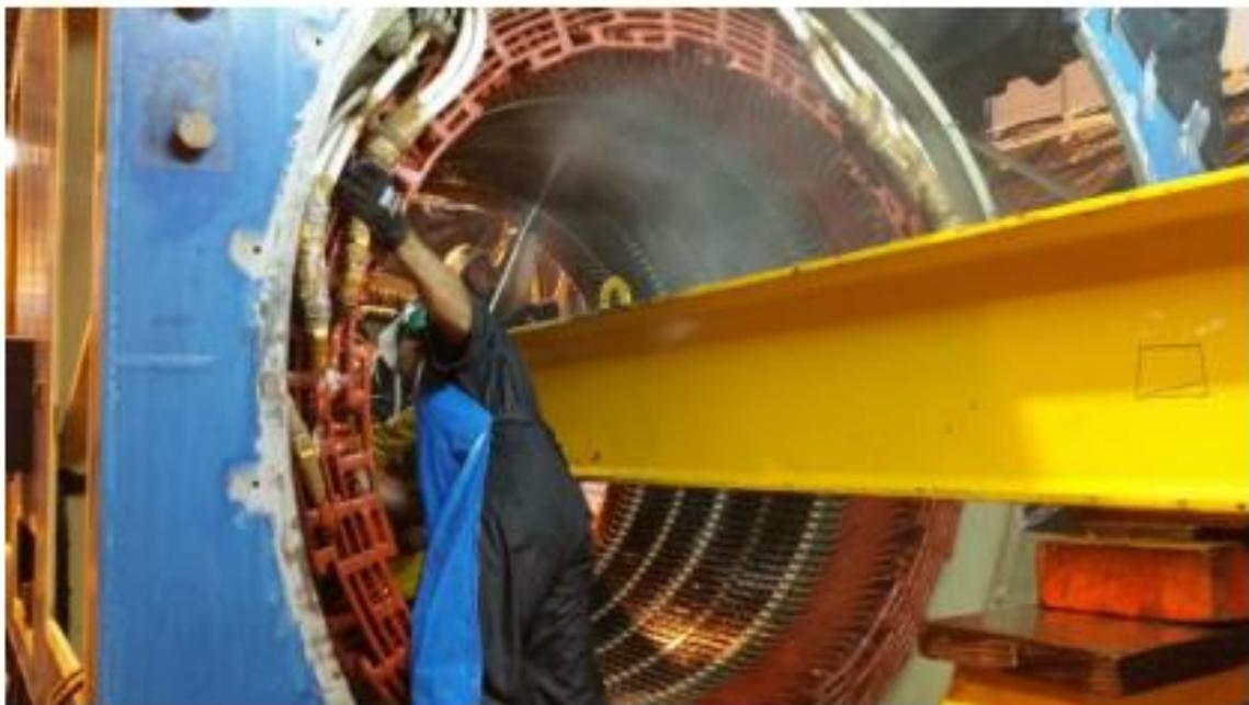
**Proceso de limpieza y lavado a presión del estator con solvente dieléctrico**
