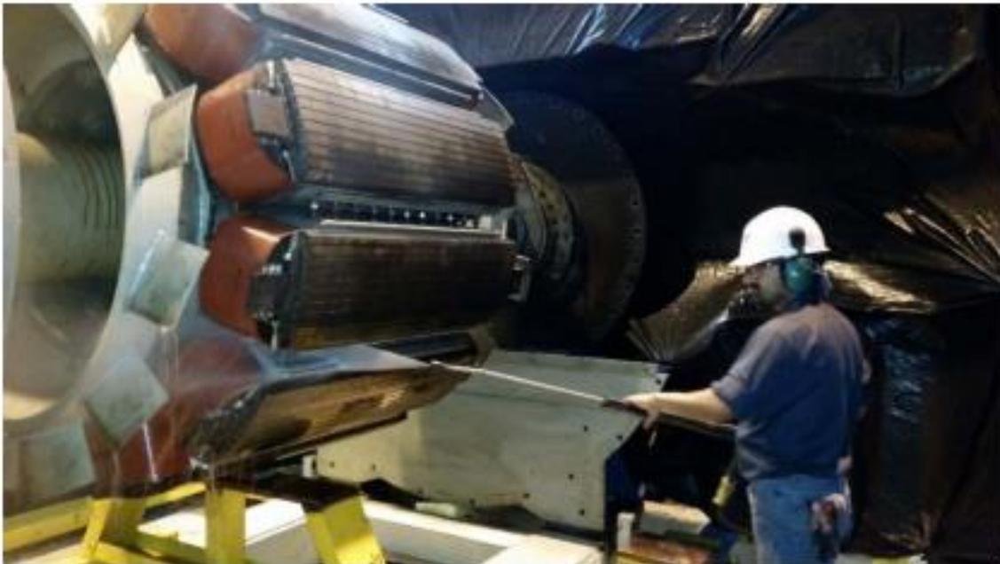
**Proceso de Limpieza a presión del rotor del generador**
