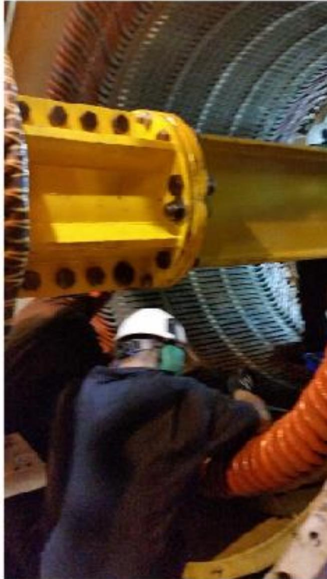
**Proceso de eliminación del silicón existente en en cabezales del estator**
