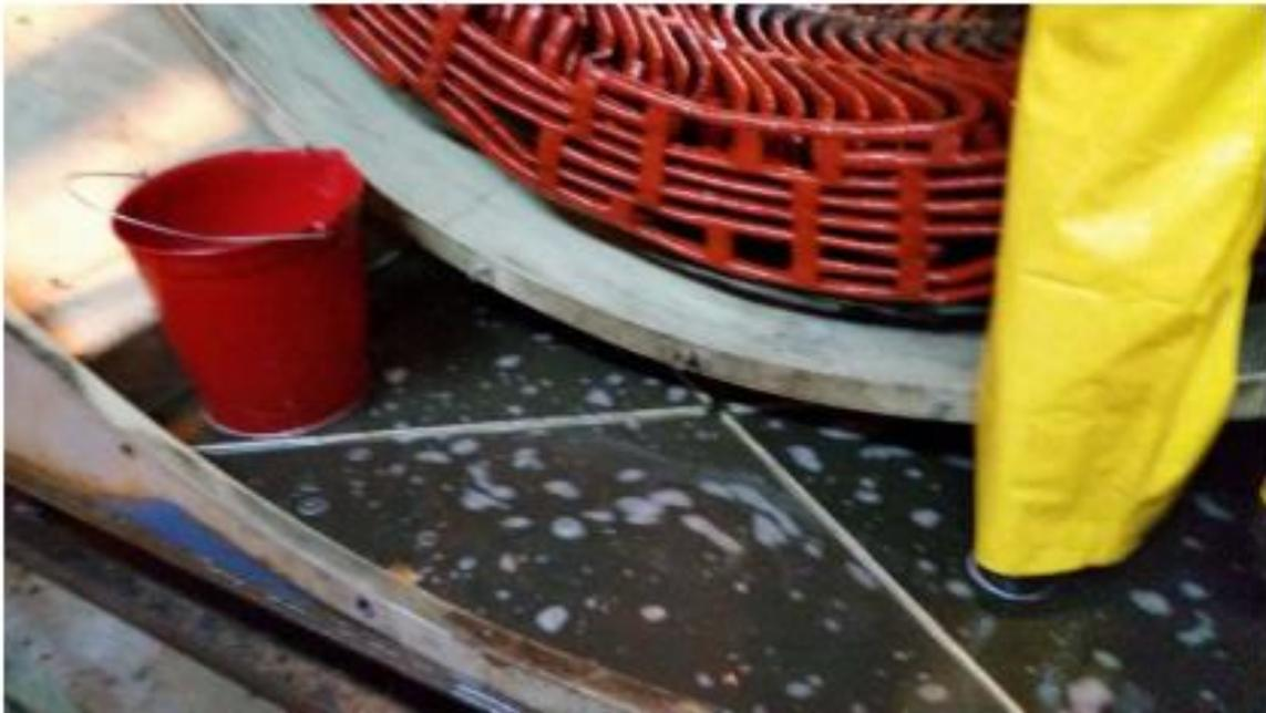
**Proceso de eliminación de contaminación del estator**
