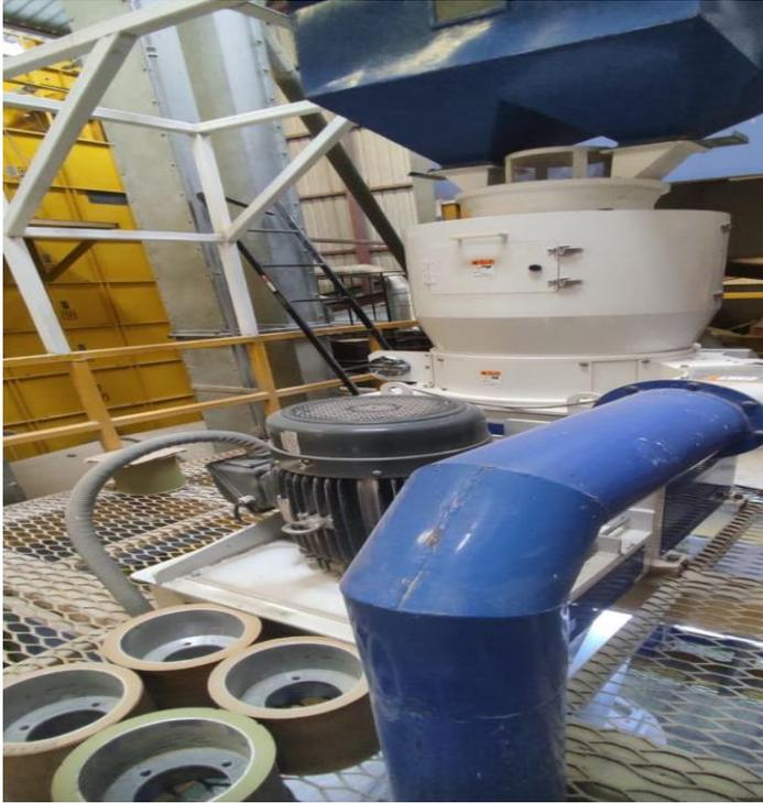
Este pulidor se encarga de blanquear el grano de arroz en su primer pase a través de fricción y aire.
