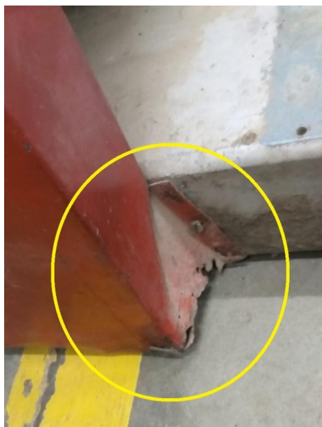
Figura 13: Presencia de golpes en la carcasa. (Fuente propia)
