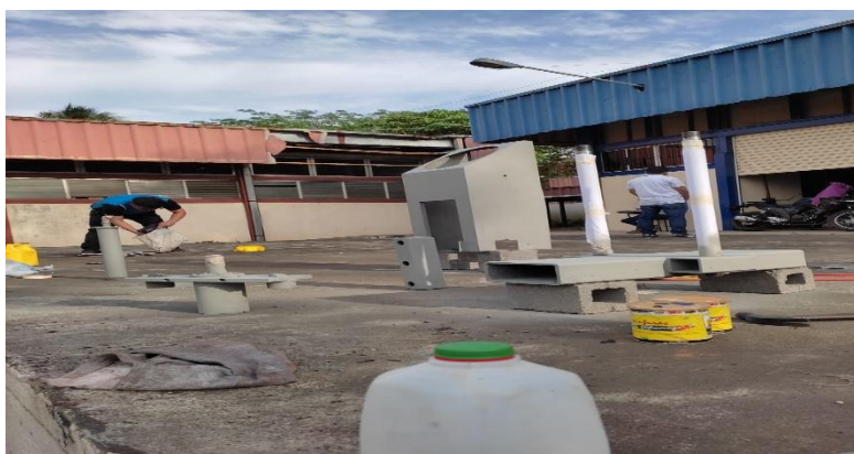
Figura 42: Aplicación de primer en componentes. (fuente propia)
