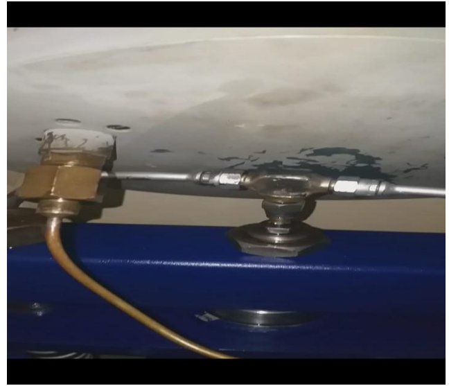
Figura 36: Detalle de accesorios conectados al manómetro del sistema, vista posterior. (fuente propia)
