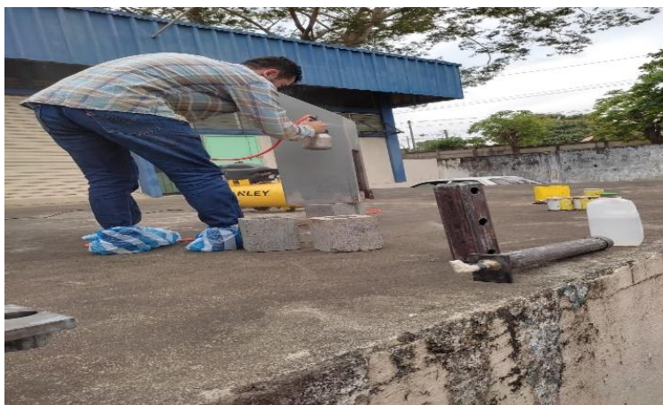
Figura 41: Aplicación de primer en estructura de la carcasa. (fuente propia)
