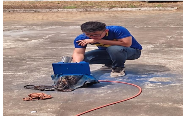
Figura 44: Aplicación de capas de acabado cabezal de compresión (fuente propia)
