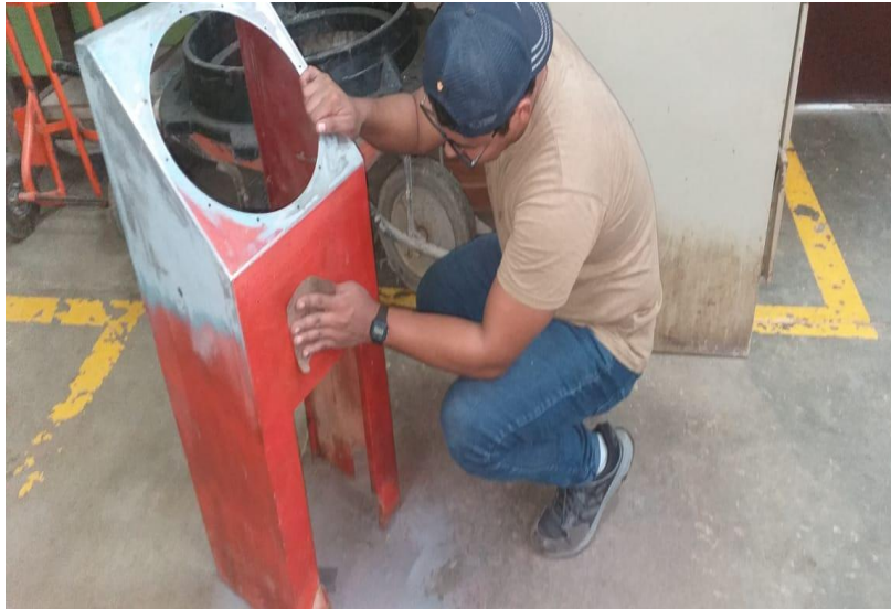
Figura 40: Lijado de la capa externa de pintura en mal estado en la carcasa metálica. (fuente propia)
