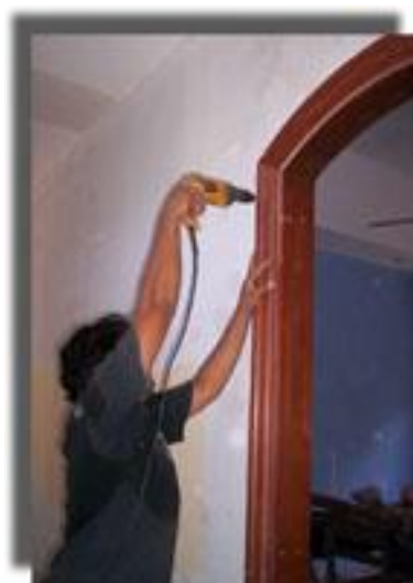
Fig. 21: Instalación del marco de una de las puertas solicitadas para elaborarse, pintarse e instalarse en el Residencial Estancia de Santo Domingo.
