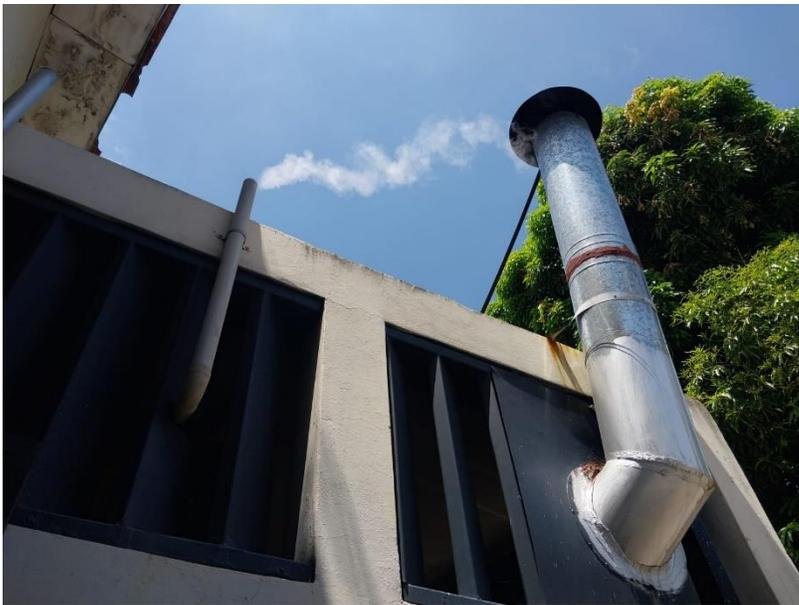
Ilustración 23 Chimenea de residuo de la caldera
